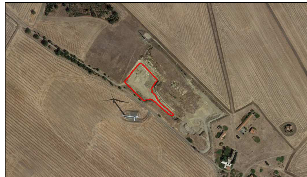
Vista aerea dell'area in cui si inserisce il sito di conferimento (da Google Earth, aggiornamento 2018).
