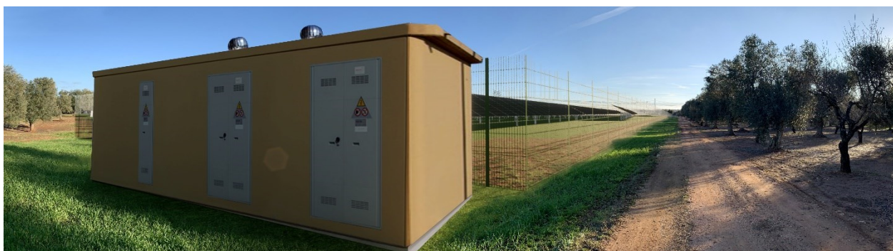
Area Nord-Ovest di impianto – post operam
