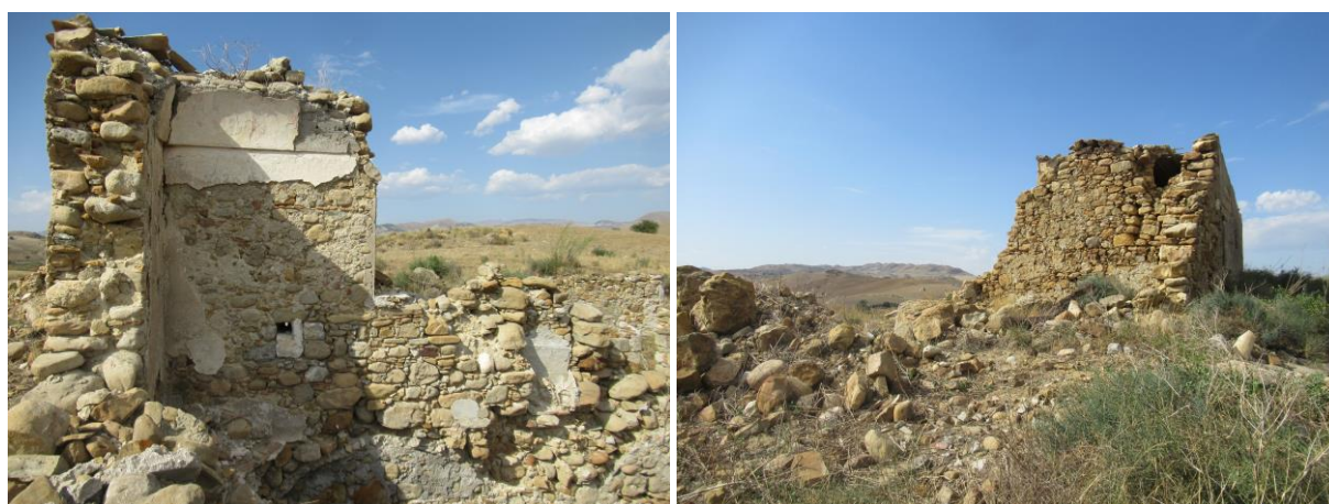
Figura 1.10: Punti di Presa Fotografica 8 e 9
