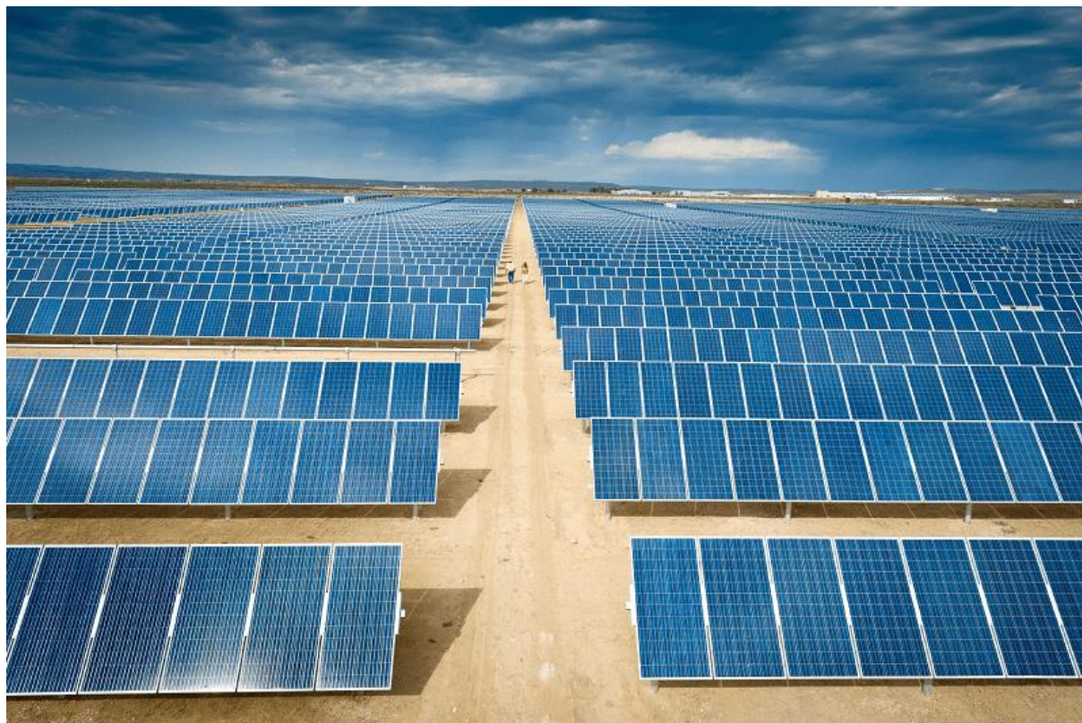
Figura 2.45: Esempio di struttura fissa
