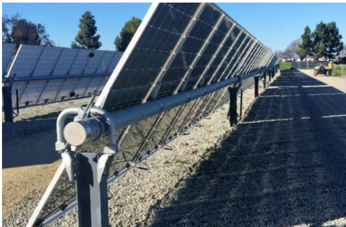
Figura 2.43: Esempio di struttura a tracker monoassiale
