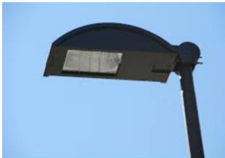
Figura 4.41: Esempio di apparecchio completamente schermato (full-cut-off).
