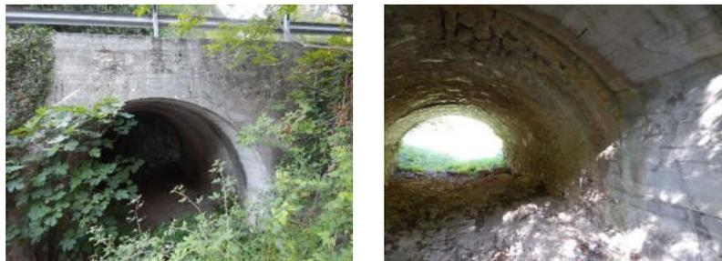
Figura 5 – Attraversamenti idraulici con soffitti a volta
