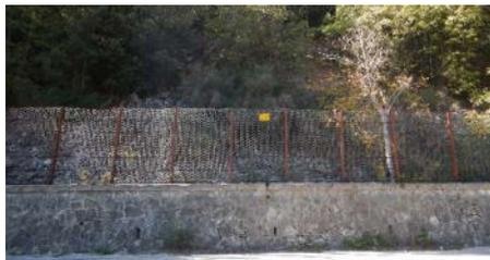
Figura 2 – Muri di controripa esistenti con rete paramassi
