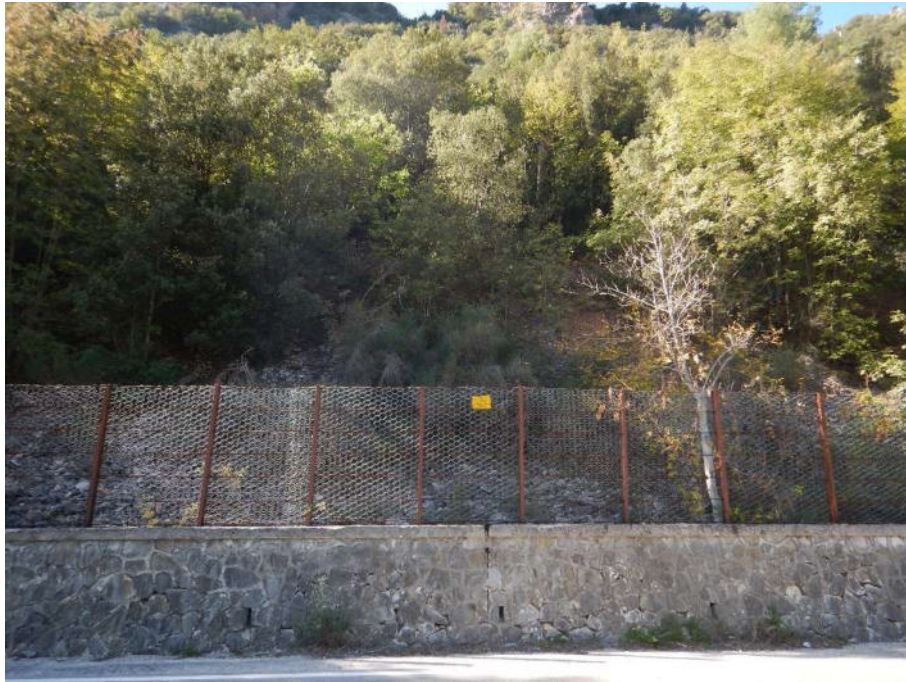
Figura 15 – Pareti rocciose riferibili alla Scaglia Rossa (Turoniano inferiore - Eocene medio) soggette a fenomeni di crollo (codice PAI UM 233), protette con reti in aderenza e barriere paramassi, Pk 1+650.
