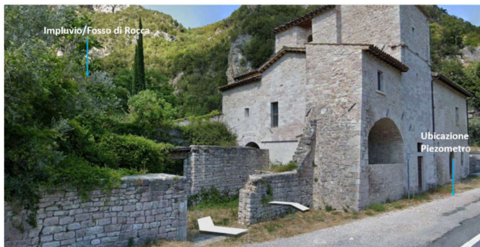
Figura 21 – Vista dell'impluvio e conoide detritico de Fosso di Rocca e ubicazione del piezometro, fronte chiesa in località l'Eremita.
