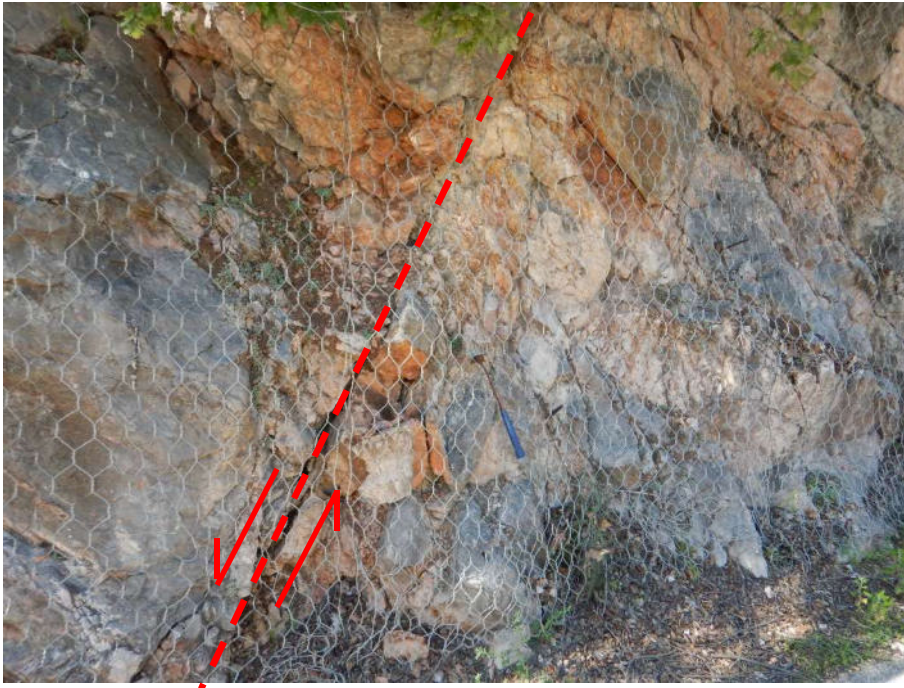
Figura 10 – Affioramento roccioso: Scaglia Rossa (Turoniano inferiore - Eocene medio); in evidenza faglia, discontinuità tettonica con associate breccie e gauge.
