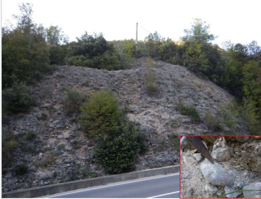
Figura 18 – Terrazzo alluvionale caratterizzato da ciottoli e blocchi da sub-arrotondati ad arrotondati con ghiaia in matrice sabbioso limosa.
