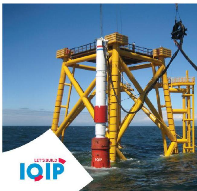
Figura 6.9 – Esempio di martello idraulico subacqueo.
