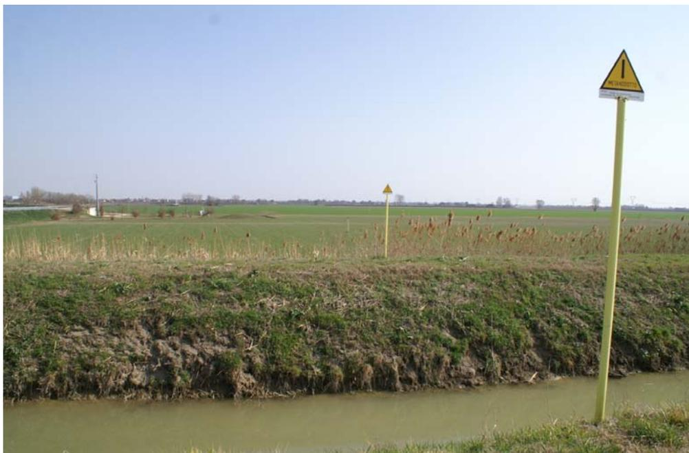
**Figura 9.1: Esempio di Elemento di Segnalazione Metanodotti**
