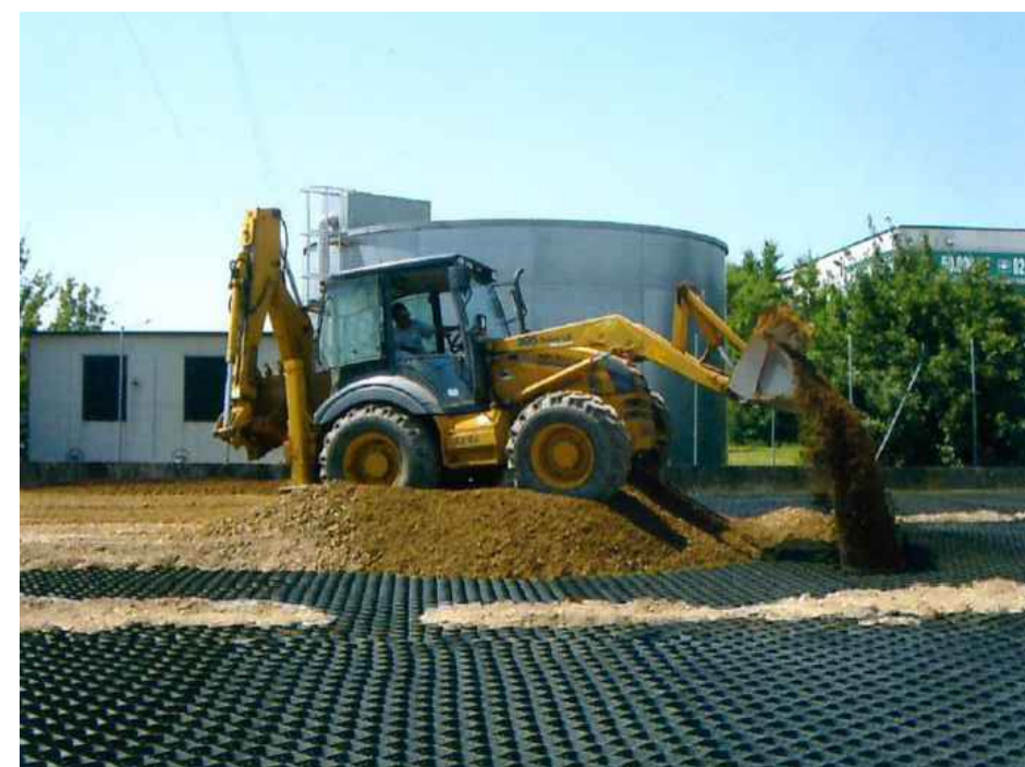
posa stabilizzante in lega polimerica
