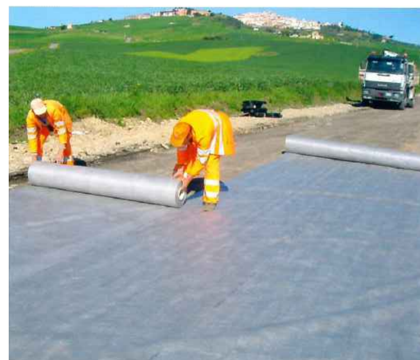
posa geostuoia di separazione
