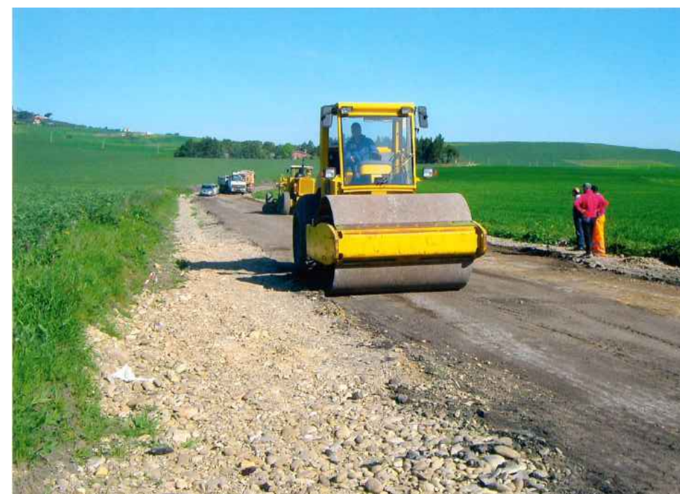
realizzazione strato di usura
