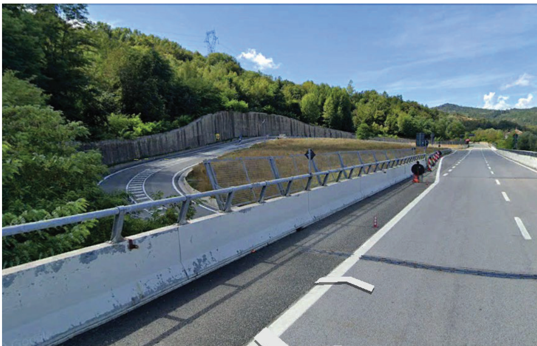
Figura 4-4 Vista d'insieme particella 7 foglio 4 Millesimo (S.A.)
