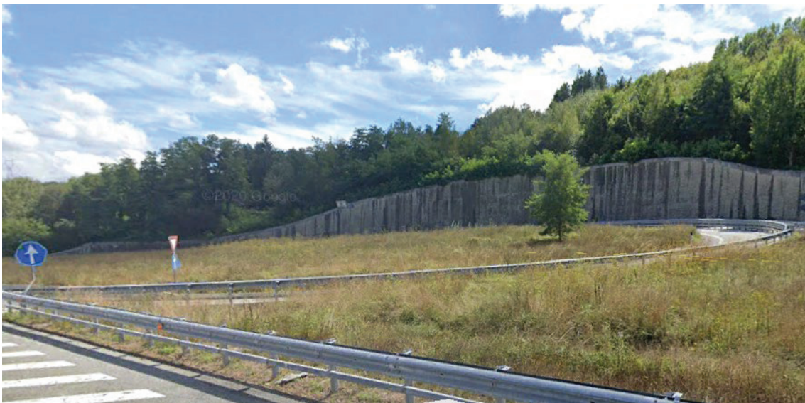
Figure 5-3 Vista area interclusa oggetto di intervento
