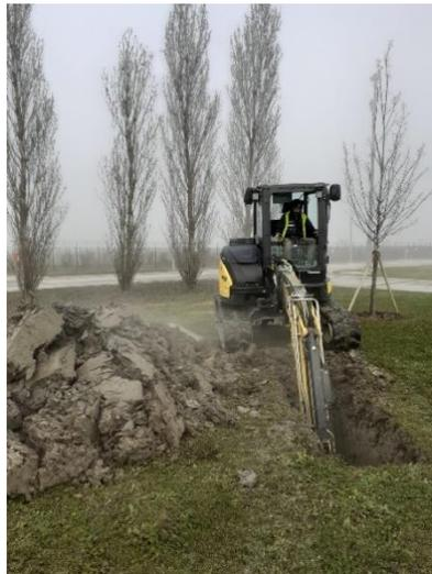
*Figura 1: prescavo sondaggio S1 – cptu1*
