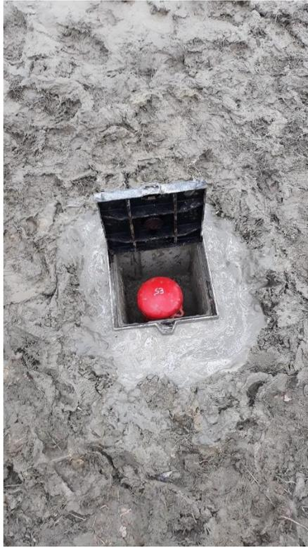
*Figura 42: completamento a piezometro del sondaggio S3*
