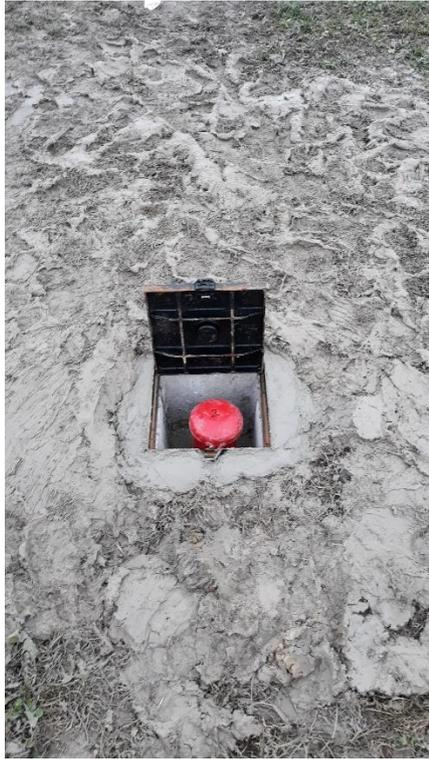
*Figura 36: completamento a piezometro del sondaggio S2*
