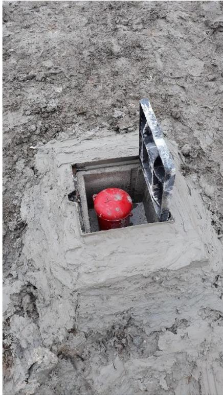
*Figura 27: sondaggio S1, completamento a piezometro con cella di Casagrande*
