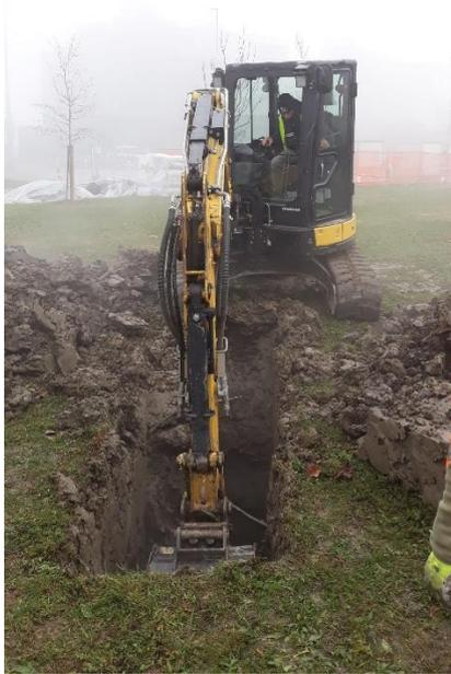
*Figura 7: prescavo sondaggio S3-cptu3*
