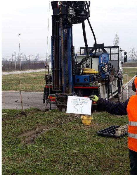
Figura 19: posizionamento sonda per esecuzione sondaggio S1
