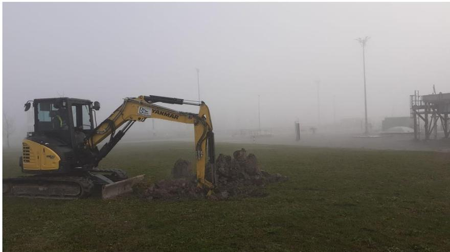
*Figura 4: prescavo sondaggio S2-cptu2*
