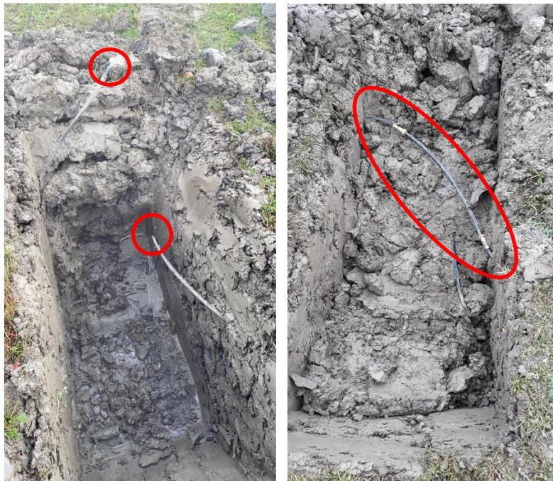
*Figura 8: rottura tubo di irrigazione nel corso del prescavo S3-cptu3 e conseguente riparazione dello stesso*
