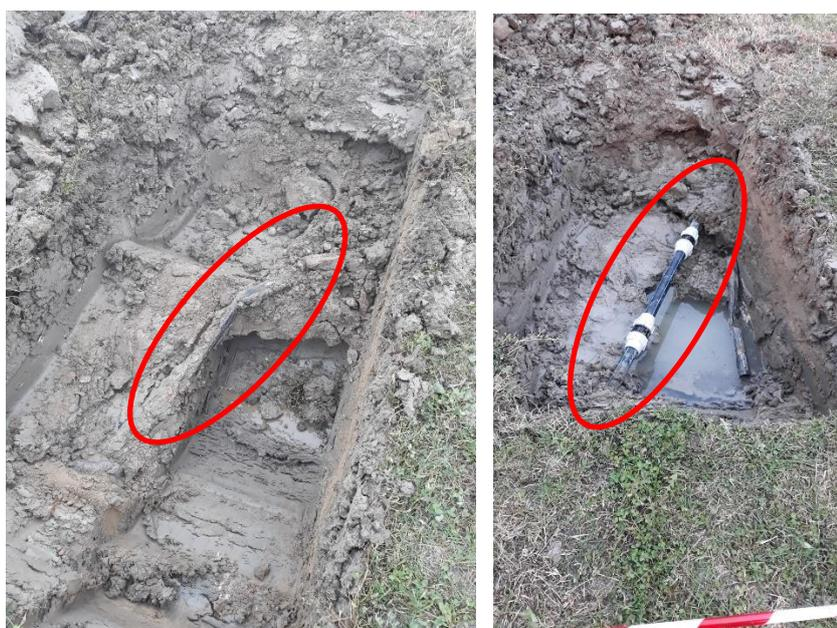
*Figura 18: rottura tubo irrigazione nel corso del prescavo AMB3 e conseguente riparazione dello stesso*
