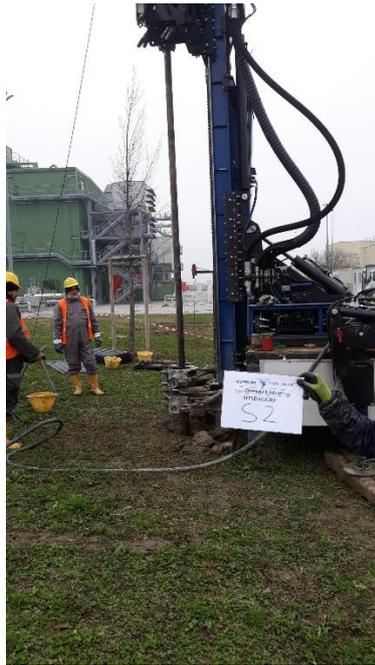
Figura 28: posizionamento sonda per esecuzione sondaggio S2
