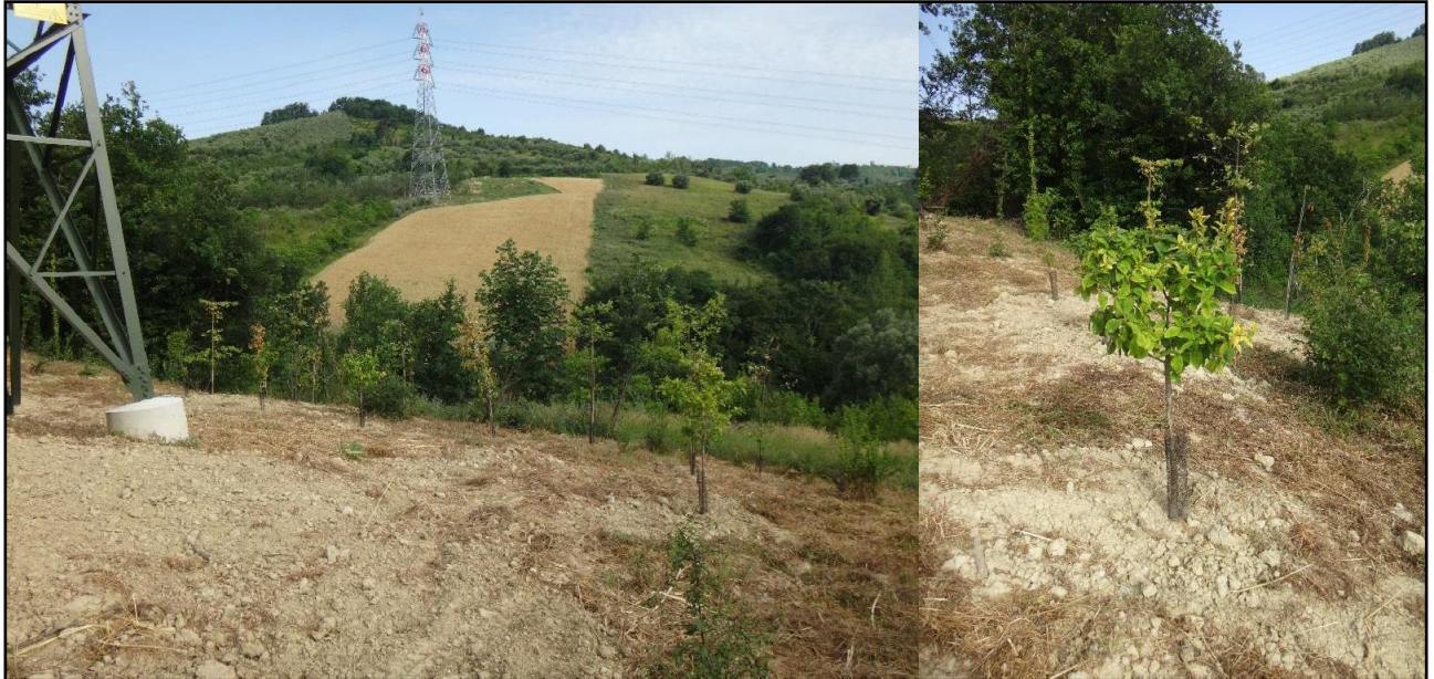
Figura 2.3.5a Esempio di ripristino di un micro-cantiere localizzato su un versante
