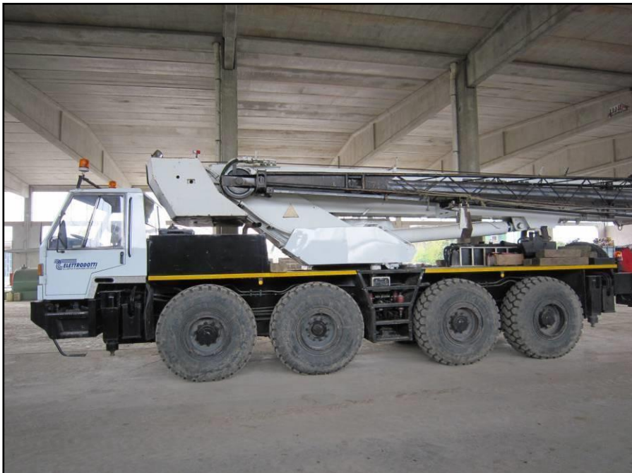
Figura 2.3.1.1f Area centrale – Mezzo utilizzato in fase di cantiere
