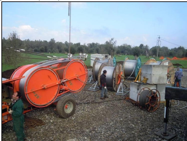
Figura 2.3.4b (1 di 3) Fasi di tesatura della linea elettrica
