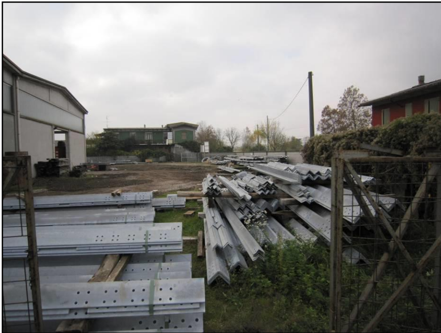
Figura 2.3.1.1e Area centrale – Deposito materiale
