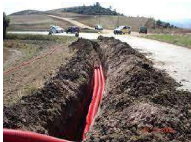
Figura 97 - Posa cavidotto MT tipo
