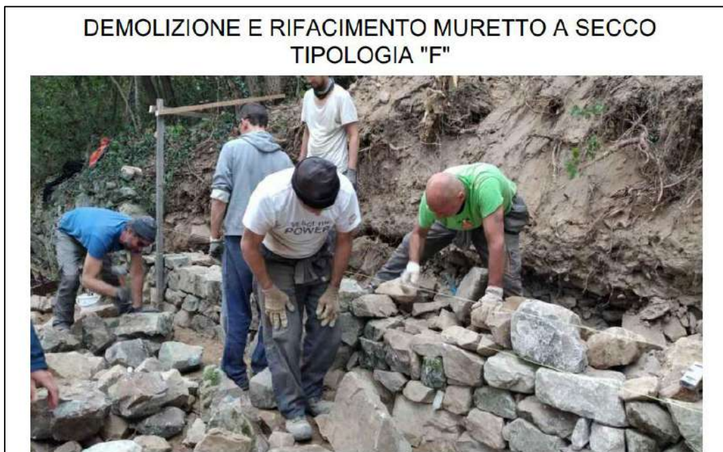
Figure 135 c – demolizione e rifacimento dei muretti a secco per la realizzazione della viabilità o delle componenti temporanee del layout impianto
