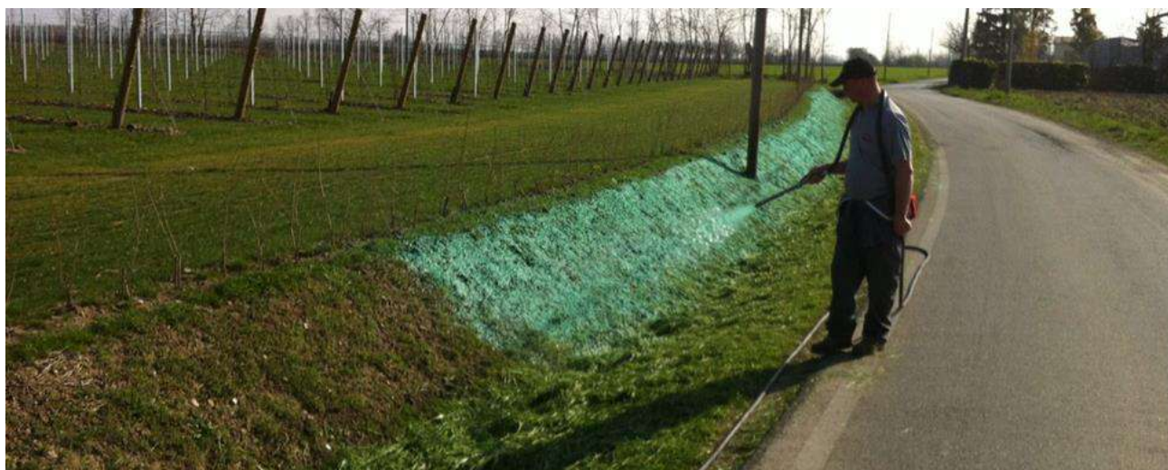
Figura 133 - Sistema di idrosemina
