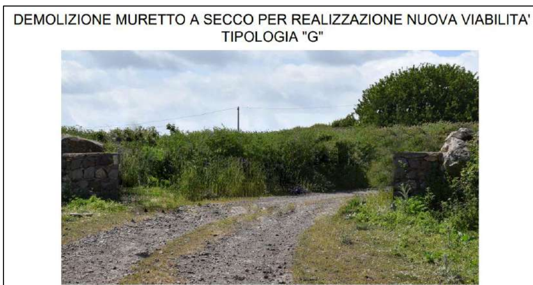
Figure 135 b – demolizione dei muretti a secco per la realizzazione di nuova viabilità
