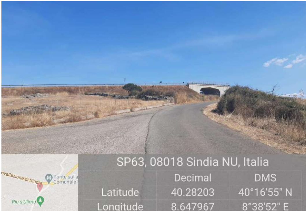
Sindia, Strada Provinciale 63: tratta interessata dal passaggio del cavidotto.
