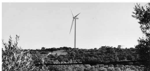
Spacchia (LE) impianto eolico comunale (potenza 660 kW altezza torre 50m)
