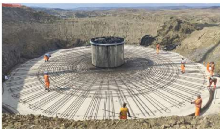
Figura 5-3: immagine tipo posa anchor cages
