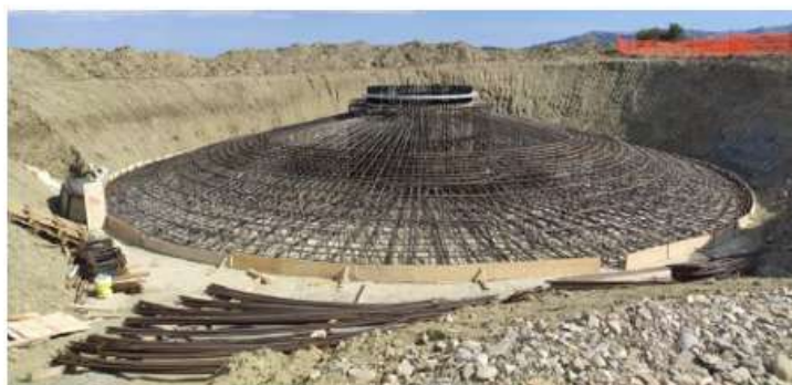
Figura 5-4: immagine tipo armature plinto
