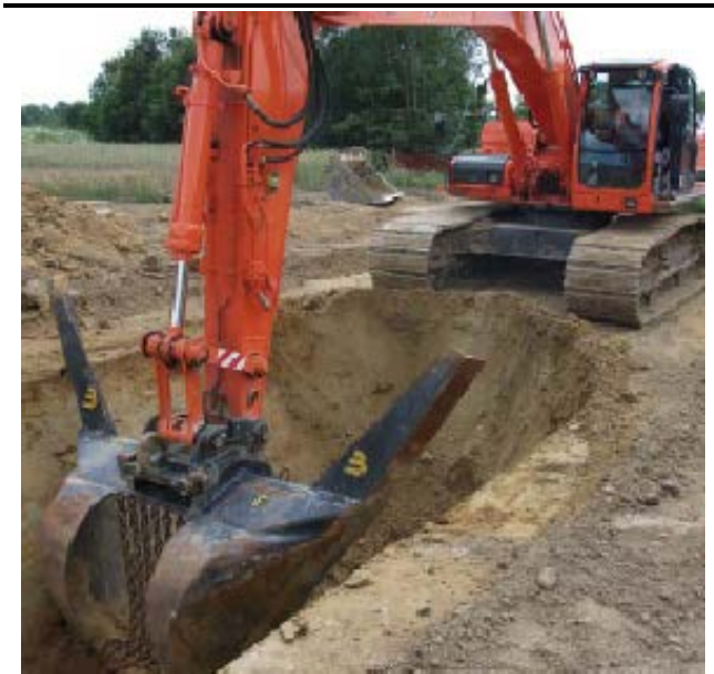
Figura 1-1 Scavo della trincea
