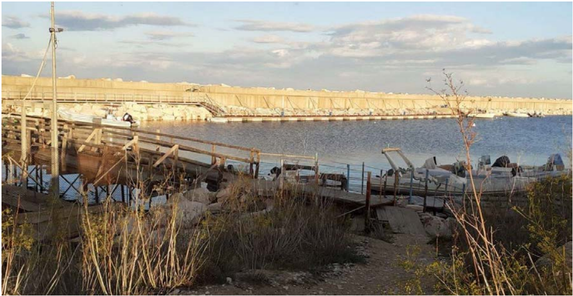
Figura 4 - Pontile galleggiante esistente (fonte: sito web Nuova Sardegna)
