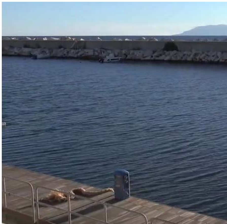
Figura 6 - Colonnina per l'approvvigionamento di servizi
