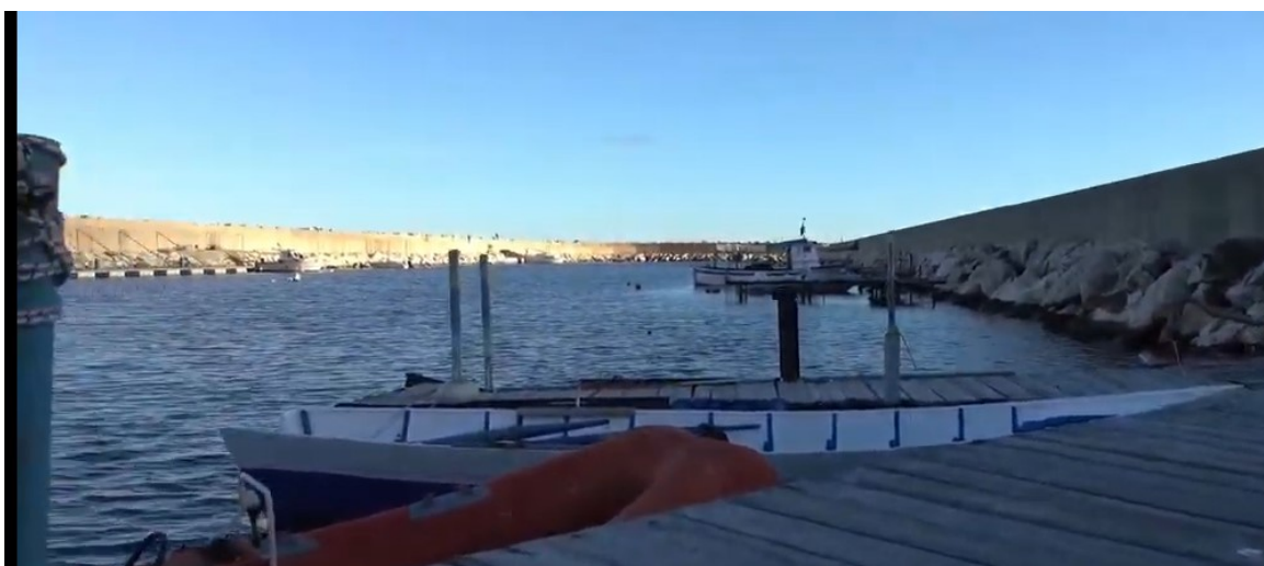
Figura 11 - vista laterale passerella esistente e molo
