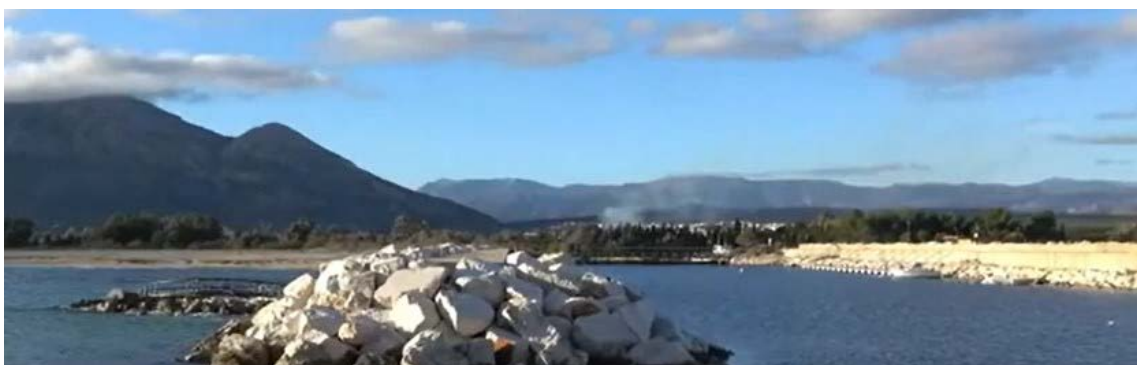
Figura 9 - vista laterale della passerella esistente
