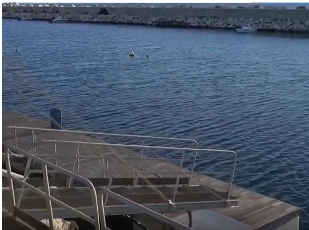
Figura 7 - Passerella di accesso al pontile
