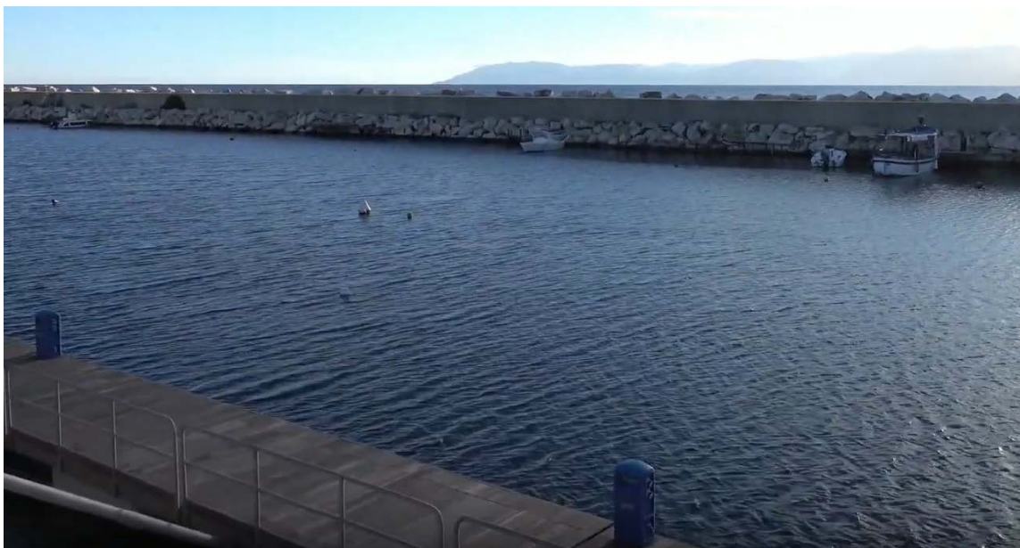
Figura 13 - colonnine esistenti e boe
