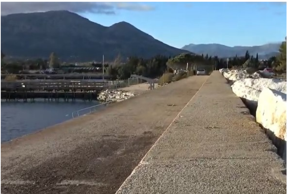
Figura 5 - Vista della passerella dall'alto
