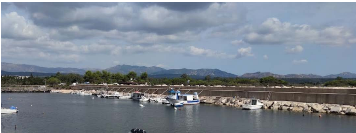
Figura 15 - vista laterale passerella e molo
