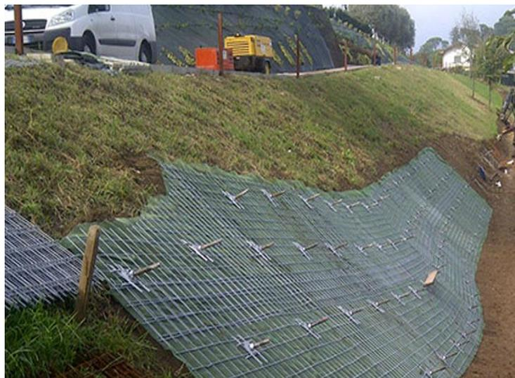
**Figura 26: Dettagli reti in acciaio**
