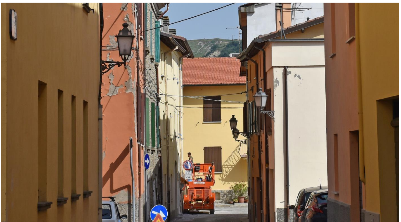
Figura 57: Ripresa fotografica n.4 - Stato ante-operam
