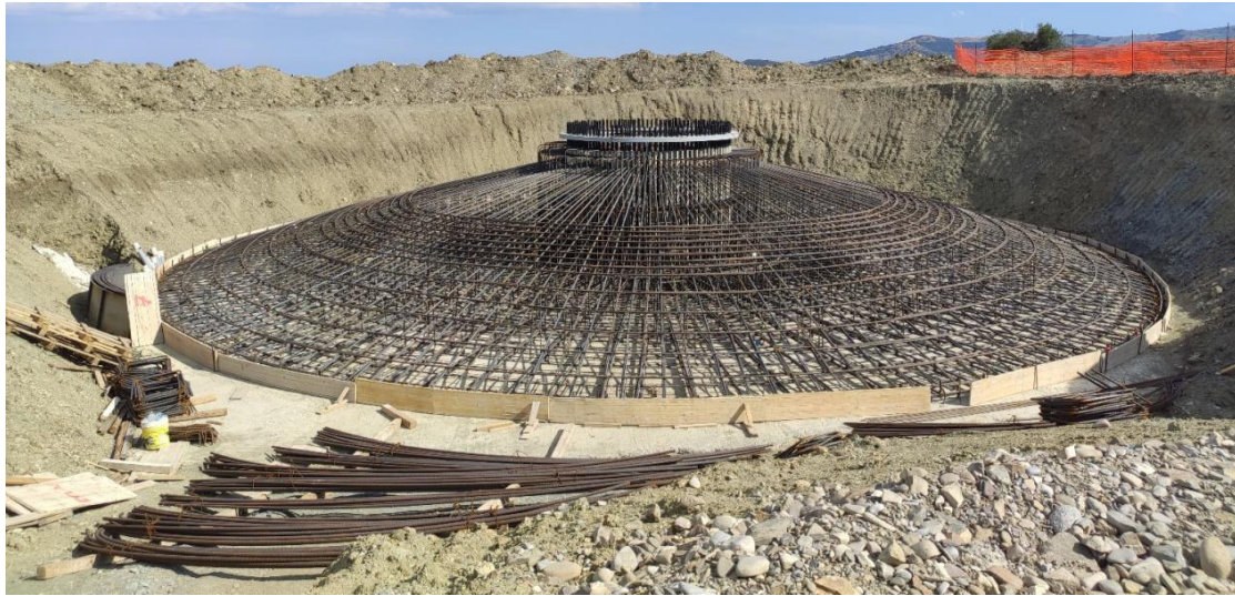
Figura 3-3: armatura plinto tipo
