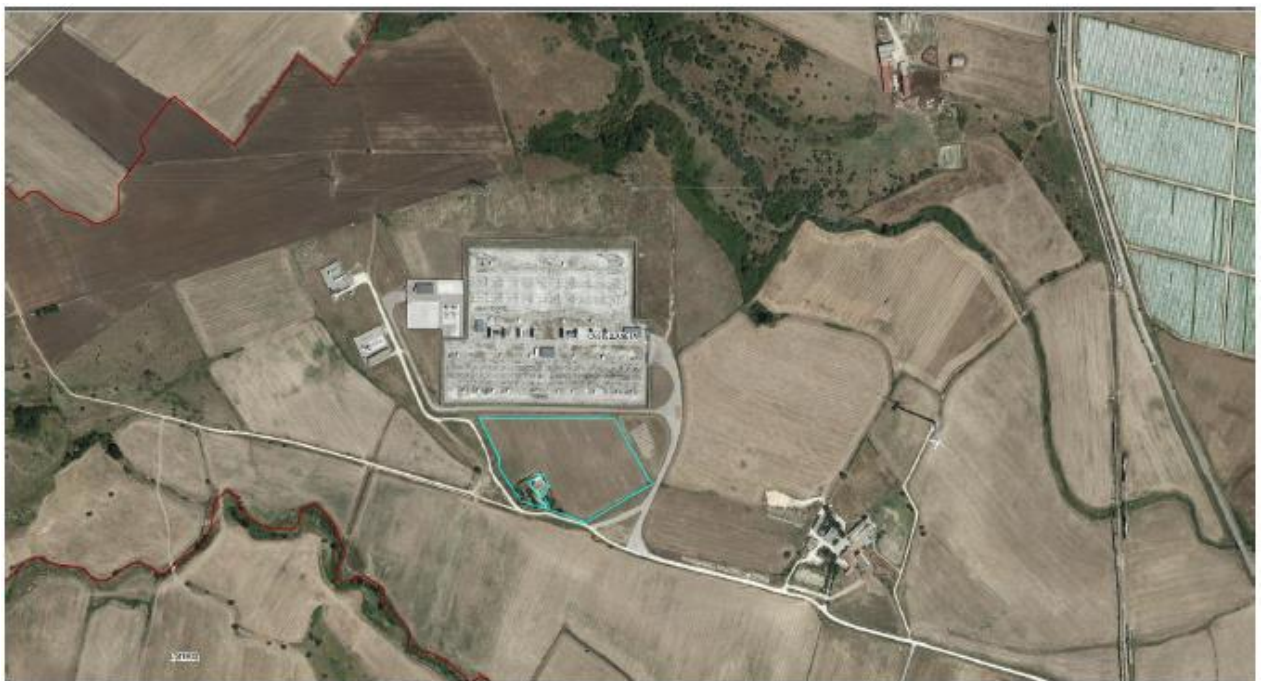
Figura 4-6: Stazione Elettrica e suo "intorno"
