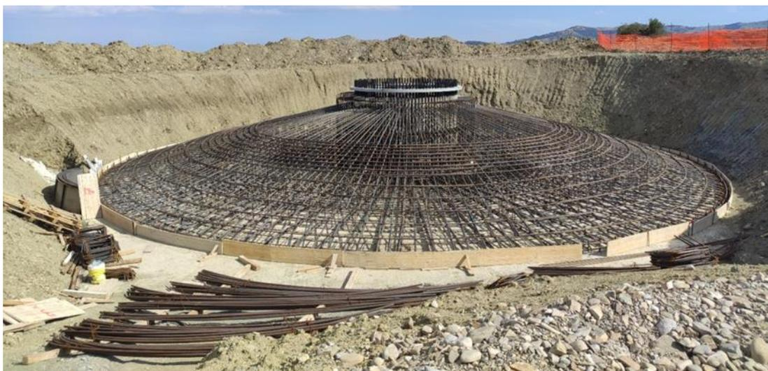
**Figura 5-4: immagine tipo armature plinto**
