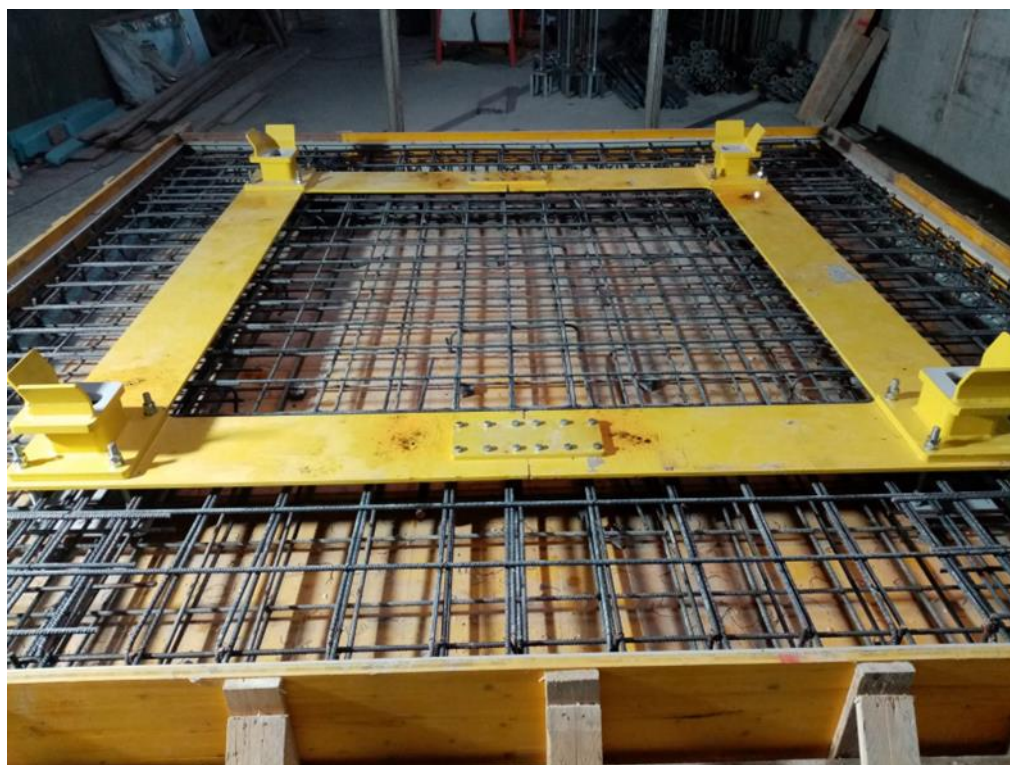
Figura 2.3 Foto di cantiere particolare armatura botola a quota 5,90
