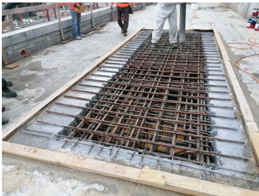
Figura 2.2 foto di cantiere getto strutturale chiusura foro a quota 12,60
