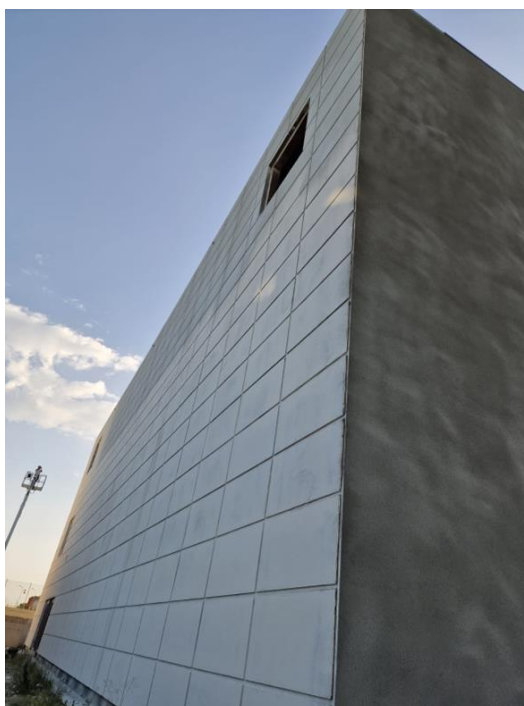
Figura 2.5 Foto di cantiere particolare posa cappotto e tinteggiatura pareti esterne
