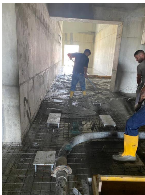
Figura 2.4 Foto di cantiere particolare armatura e getto massetto a quota 0,00
