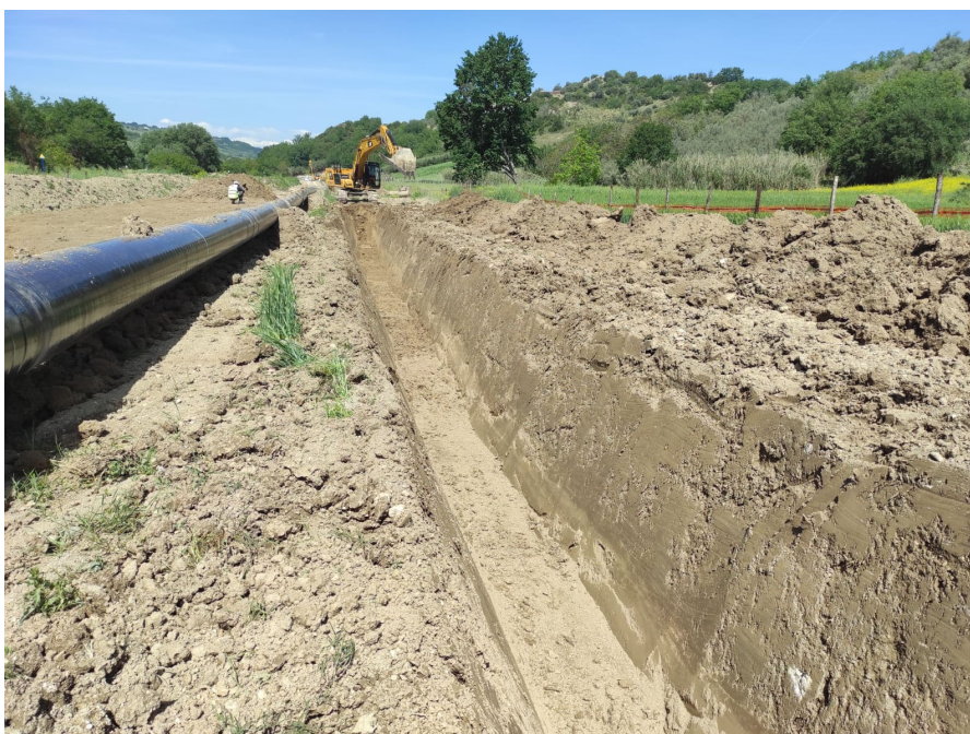
Fig. 9/B: Scavo della trincea – separazione tra terreno scavato (a destra) e l'humus precedentemente accantonato (a sinistra)
