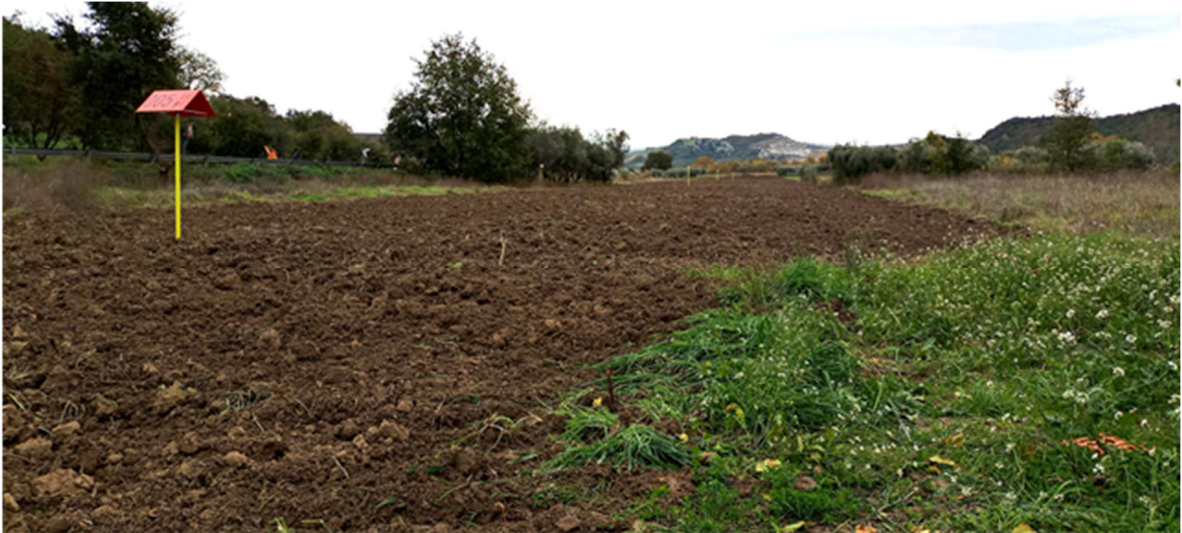
Fig. 9/D: Ripristino definitivo dello strato di terreno superficiale (humus)
