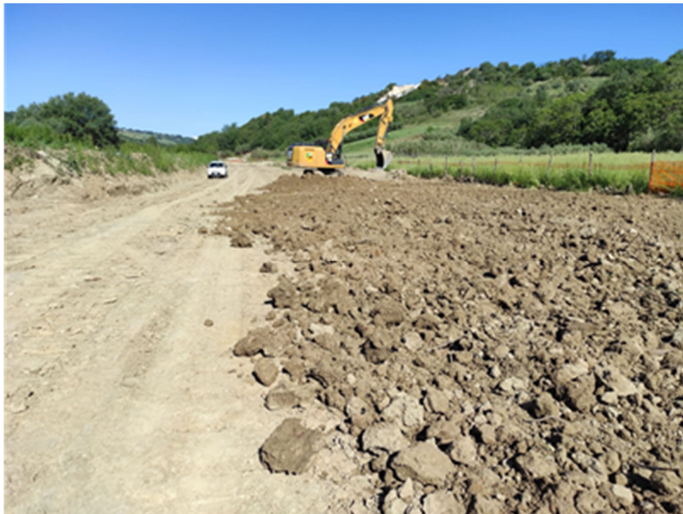
Fig. 9/C: Preparazione dello strato di contatto terreno-humus (riprofilatura)
