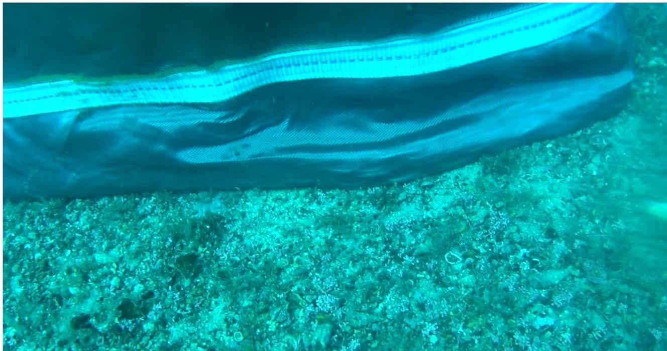
*Figura 4 – Evidenza installazione panne sino alla profondità del fondale*
