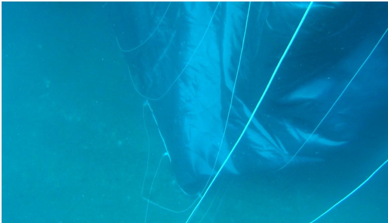
*Figura 2 – Evidenza installazione panne sino alla profondità del fondale*
