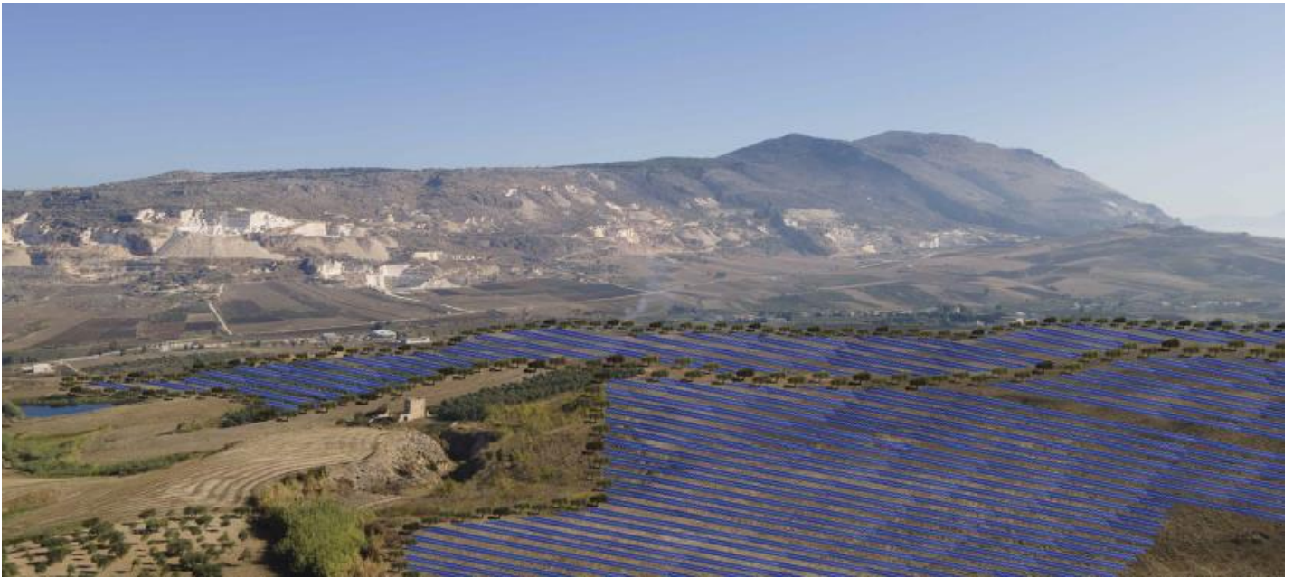
CONO A - stato POST operam impianto "Buseto 99"
