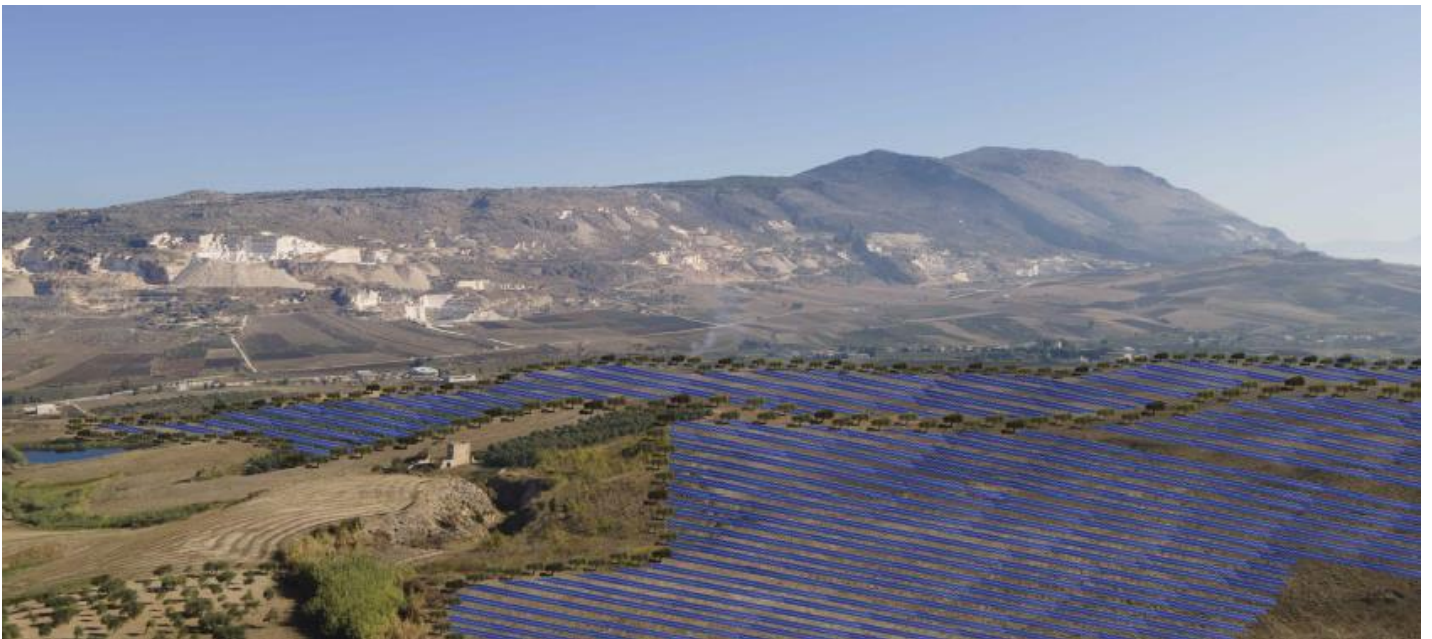
CONO A - stato POST operam impianto "Buseto 99"
