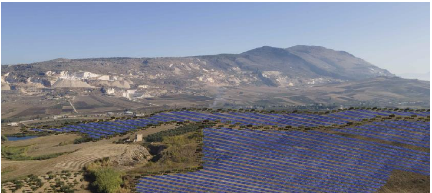
CONO A - stato POST operam impianto "Buseto 99"
