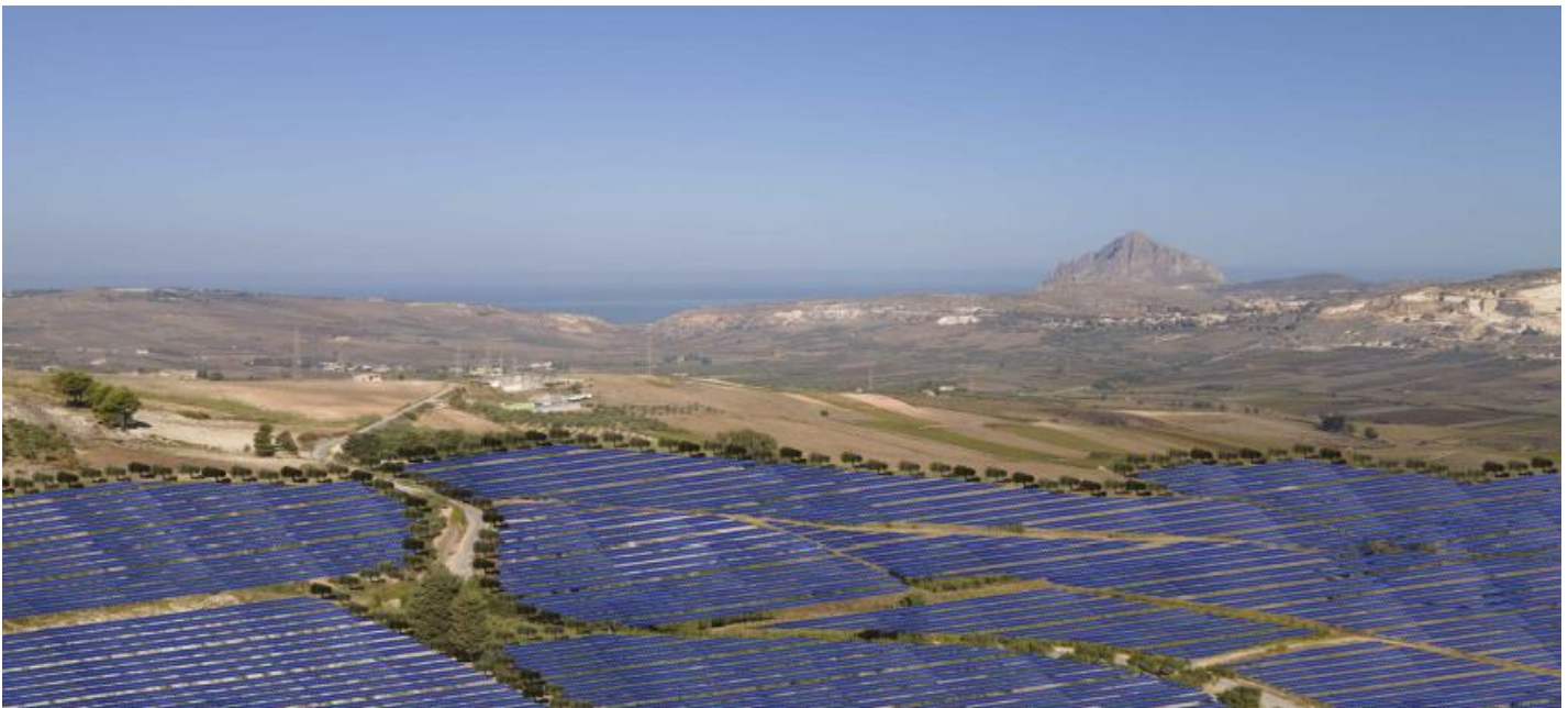
CONO B – stato POST operam impianto “Buseto 99”
