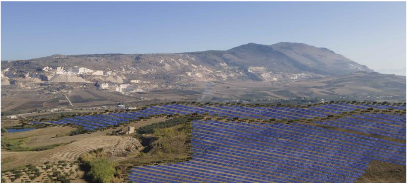
CONO A - stato POST operam impianto "Buseto 99"
