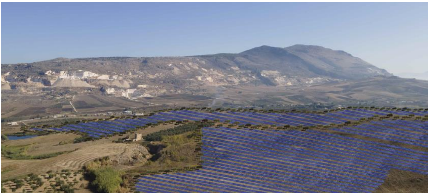
CONO A - stato POST operam impianto "Buseto 99"
