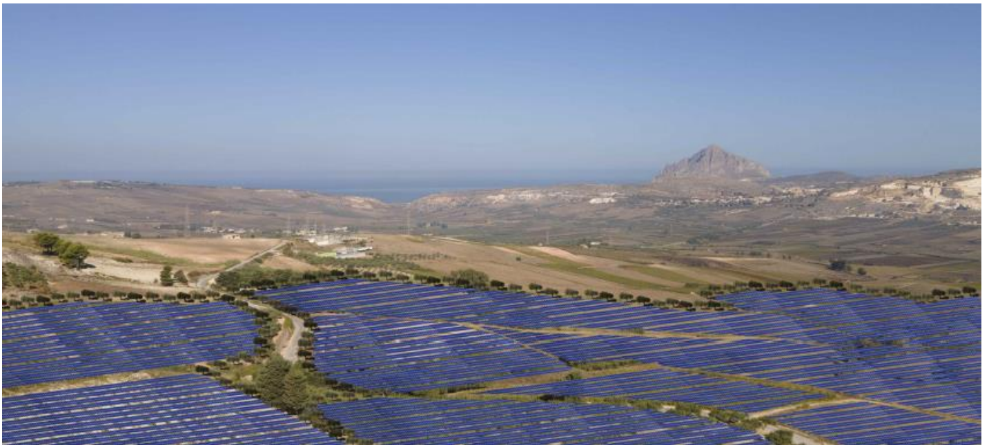
CONO B – stato POST operam impianto “Buseto 99”
