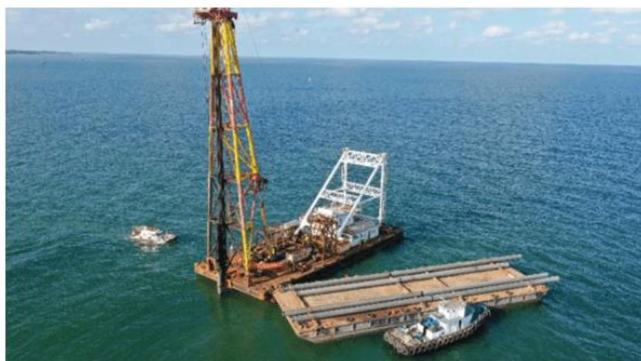
Figura 65: Installazione pali di fondazione tramite piling barge
