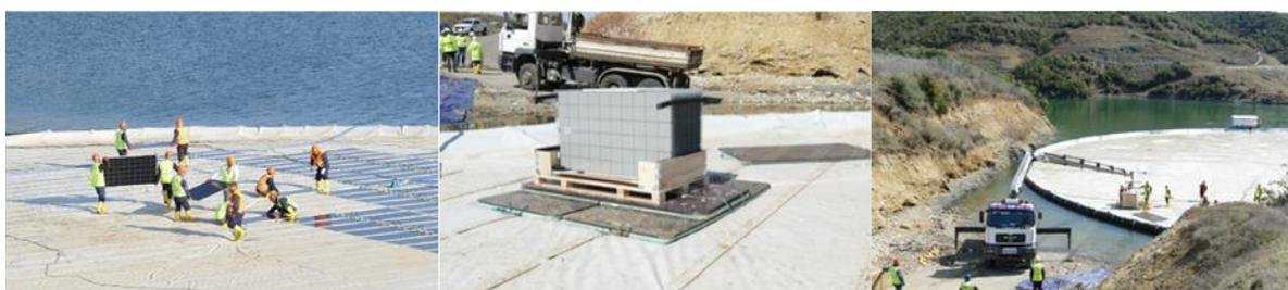
Figura 16: Installazione dei moduli fotovoltaici
