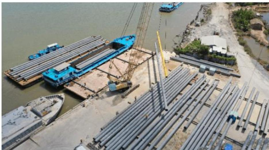
Figura 64: Operazioni di carico in porto dei pali per la fondazione multipalo
