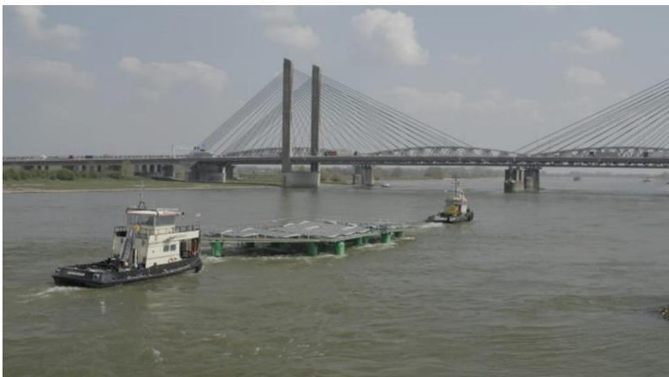
*Figura 18: Trasporto piattaforma triangolare tramite rimorchiatori*
