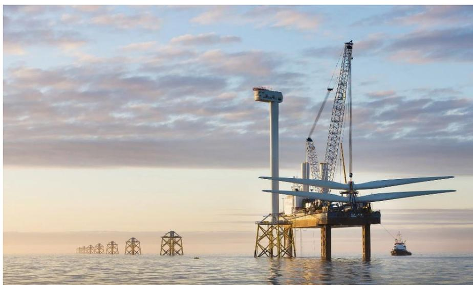
*Figura 72: Esempio di trasporto unità rotore e pale preassemblate*
