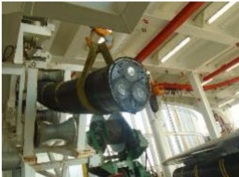
*Figura 88: Estremità di cavo tagliato durante le operazioni di installazione*
