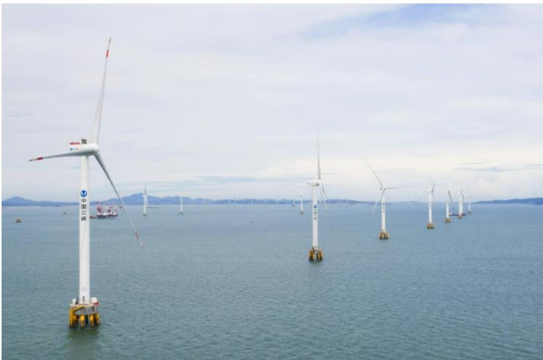
Figura 68: Esempio impianto eolico con fondazioni multipalo installate
