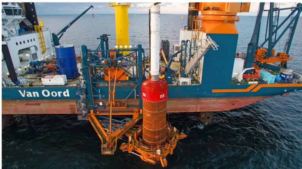
Figura 55: Battitura del monopalo tramite apposito martello
