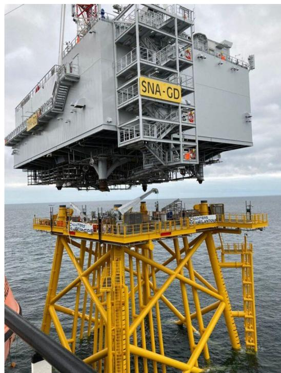
Figura 84: Installazione topside sottostazione
