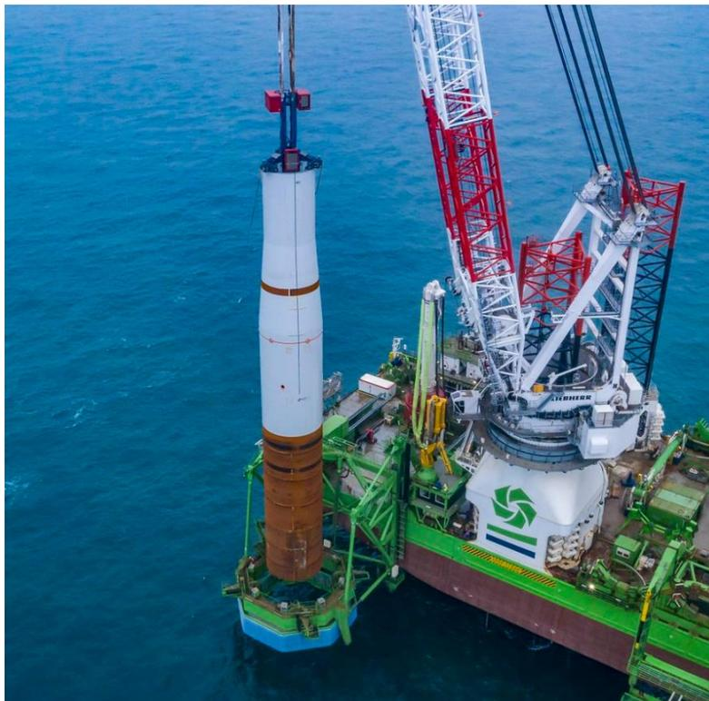
Figura 54: Posizionamento del monopalo nel gripper per l'installazione
