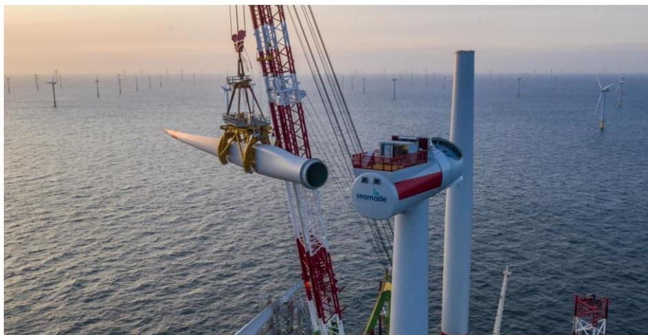
Figura 70: Esempio installazione pala
