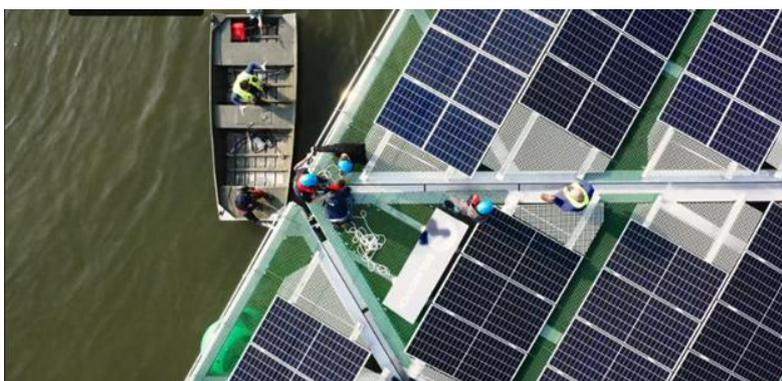
Figura 28: Installazione sistemi di ancoraggio in sito
