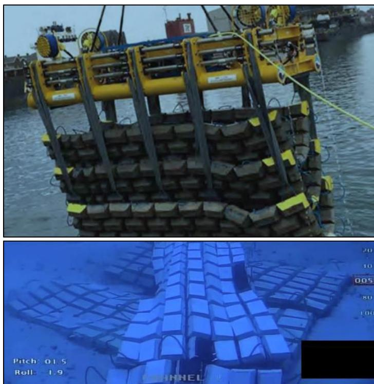
*Figura 92: Esempio di lancio dei materassi ed installazione*
