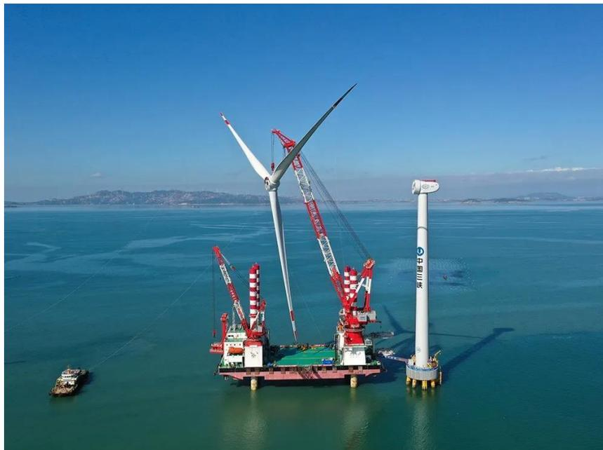
Figura 73: Esempio di installazione unità rotore e pale preassemblate
