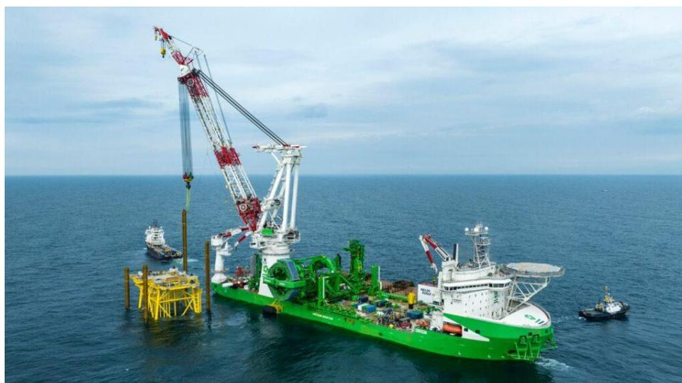
Figura 82: Verticalizzazione ed installazione pali
