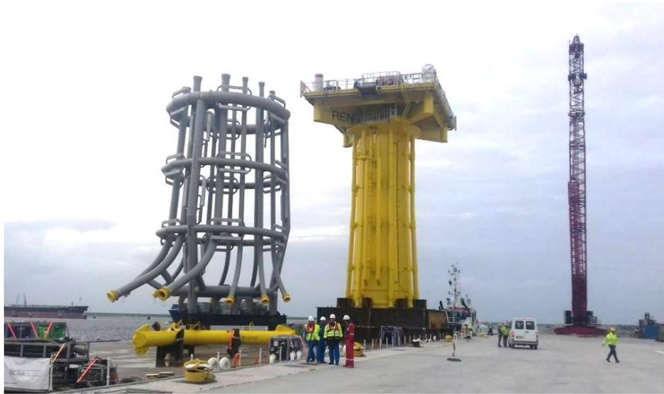
Figura 79: Gabbia con protezione catodica e J-tubes, elemento di transizione per sottostazione (in giallo)
