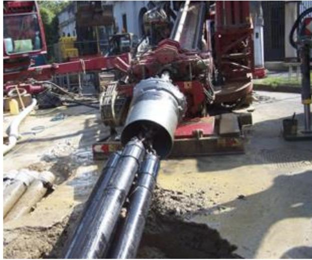
Figura 101: Schema tiro delle tubazioni
