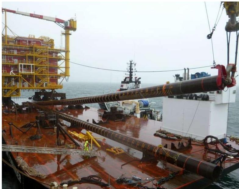
Figura 81: Verticalizzazione pali
