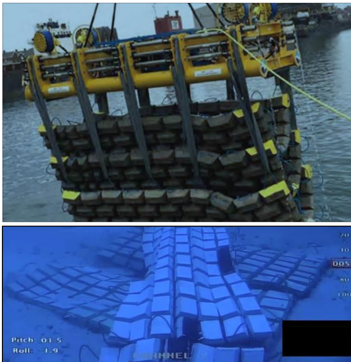
Figura 48: Esempio di lancio dei materassi (sopra) e installazione (sotto)
