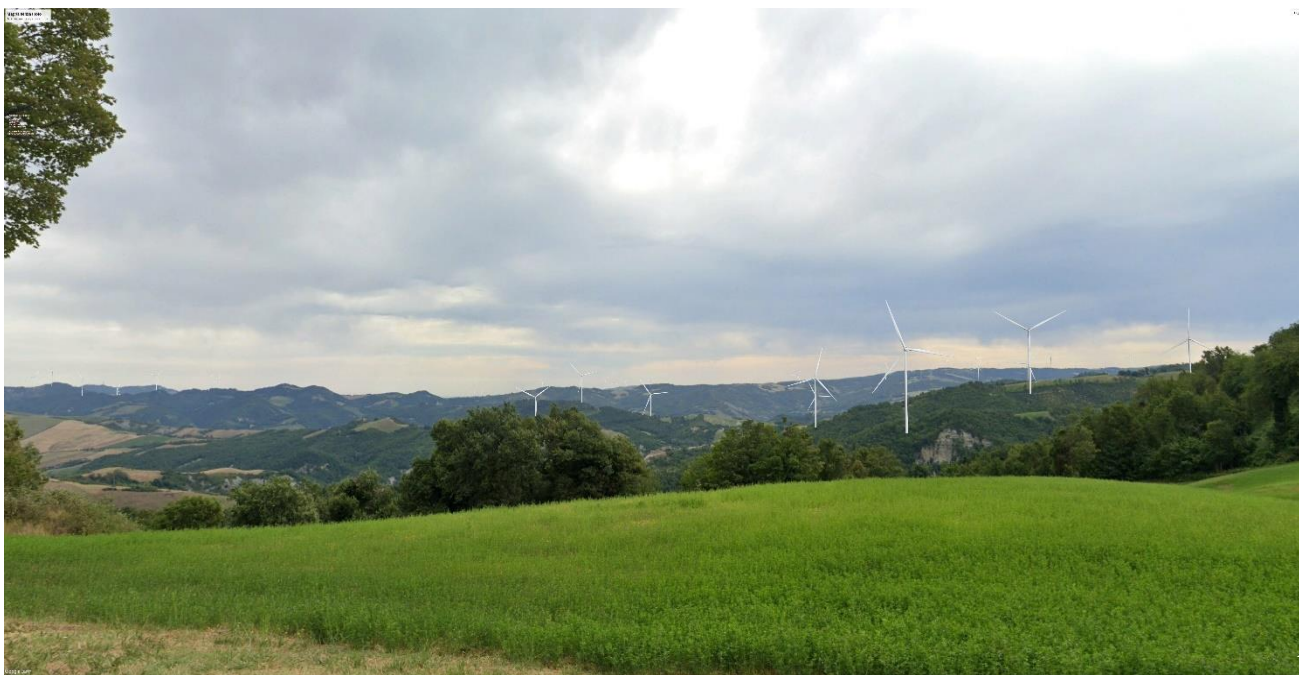
Figura 35: Cluster 1-2-3-4 – Punto di ripresa fotografica 44,290663° 11,338559°, post operam , fonte Google
