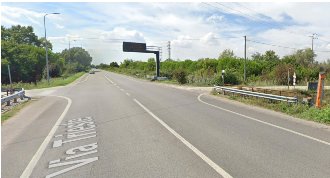
Figura 44: Immagine street view da via Trieste verso Ravenna, attuale intersezione con via dell'idrovora.
