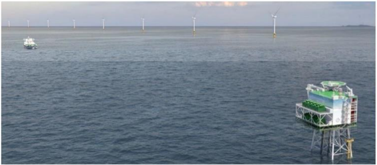
Aerogeneratori e Sottostazione Offshore
