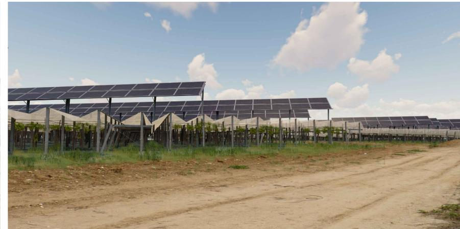
FOTOINSERIMENTO DELLE STRUTTURE FOTOVOLTAICHE INTEGRATE AL VIGNETO A TENDONE
