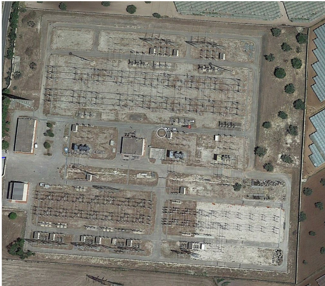
Figura 10: stazione elettrica di trasformazione di Chiamonte Gulfi
