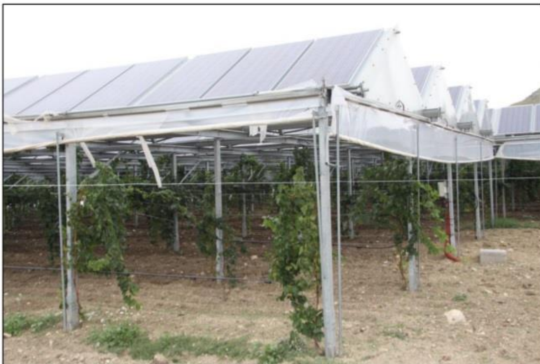
Figura 5 – Impianto fotovoltaico su vigneto a tendone
