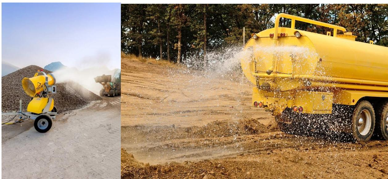
Figura 1 – Esempio di Irrorazione delle aree di cantiere
