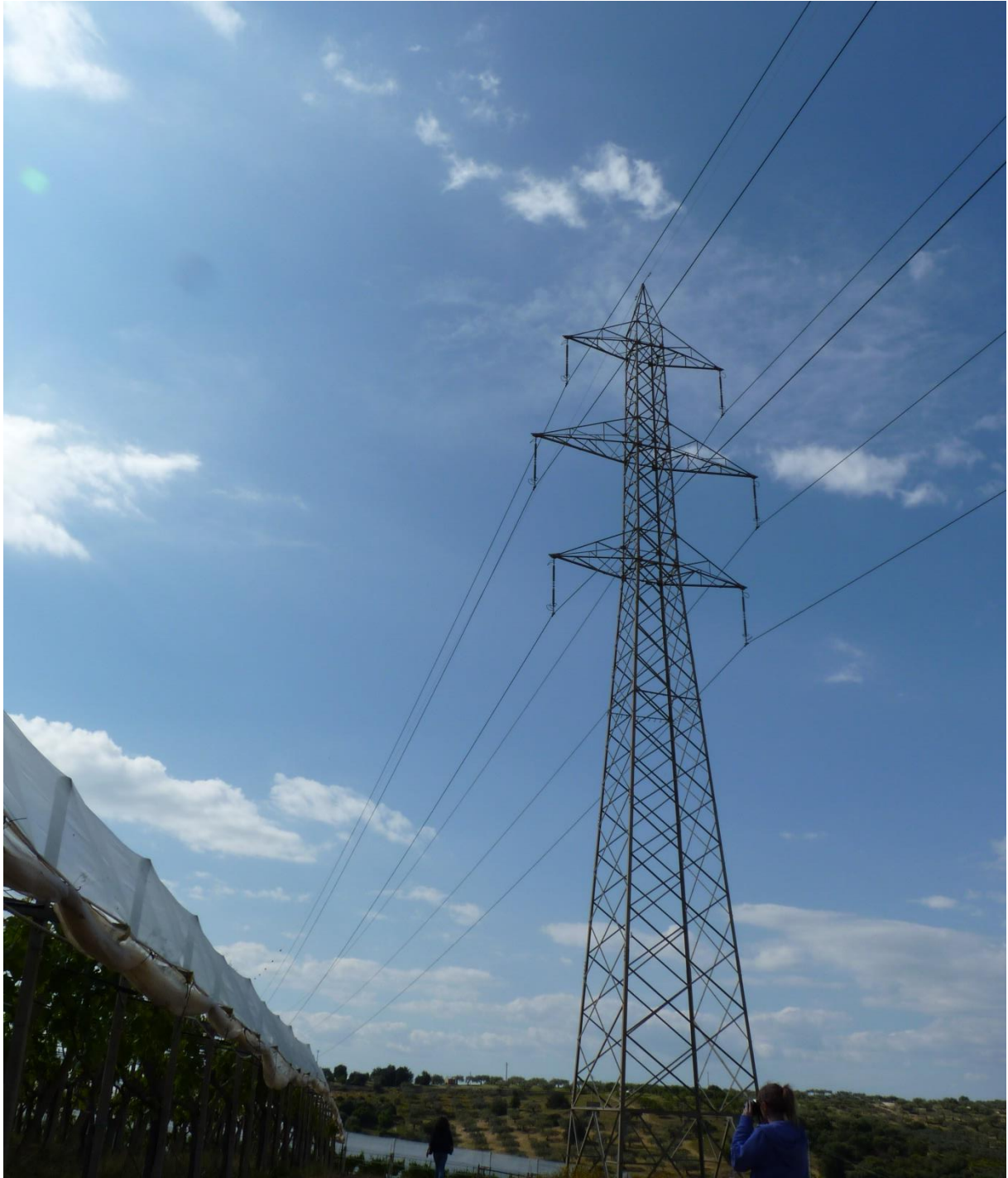
Figura 8 – Fotografia della linea aerea che attraversa l'impianto
