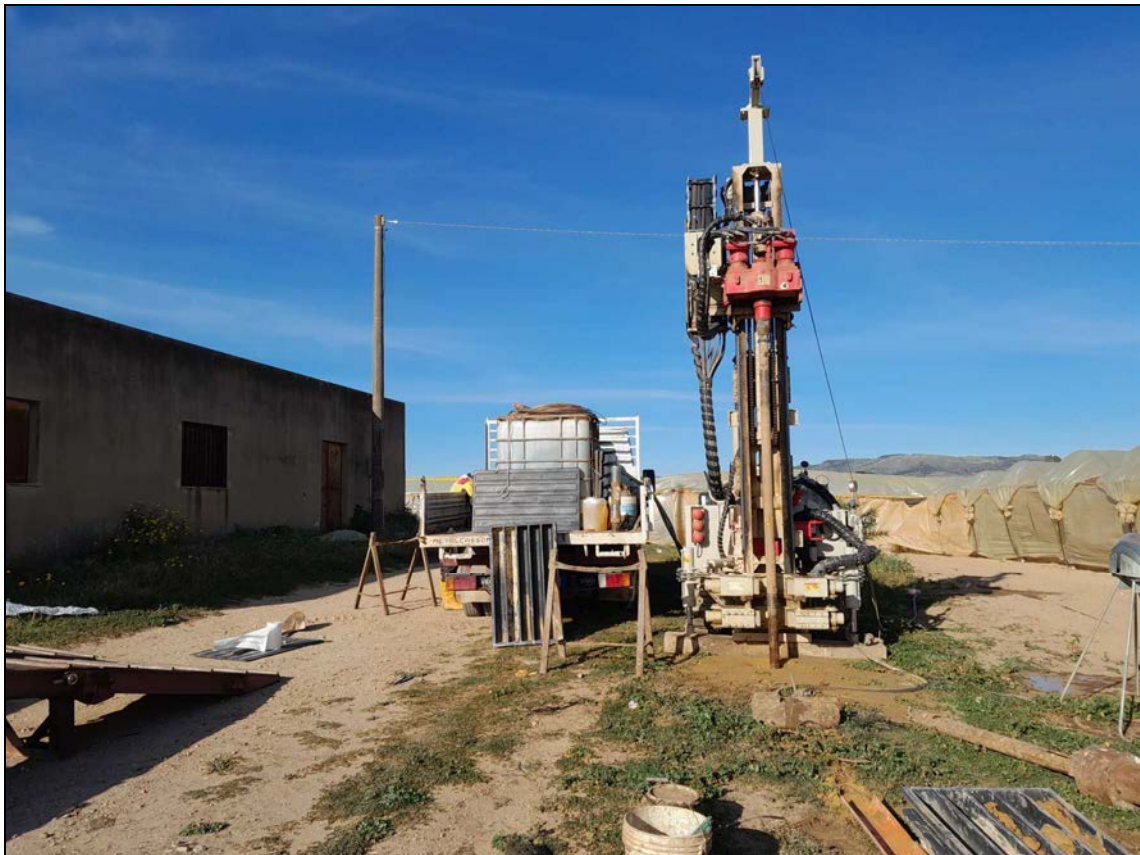
Sonda posizionata durante l'esecuzione del sondaggio meccanico 3
