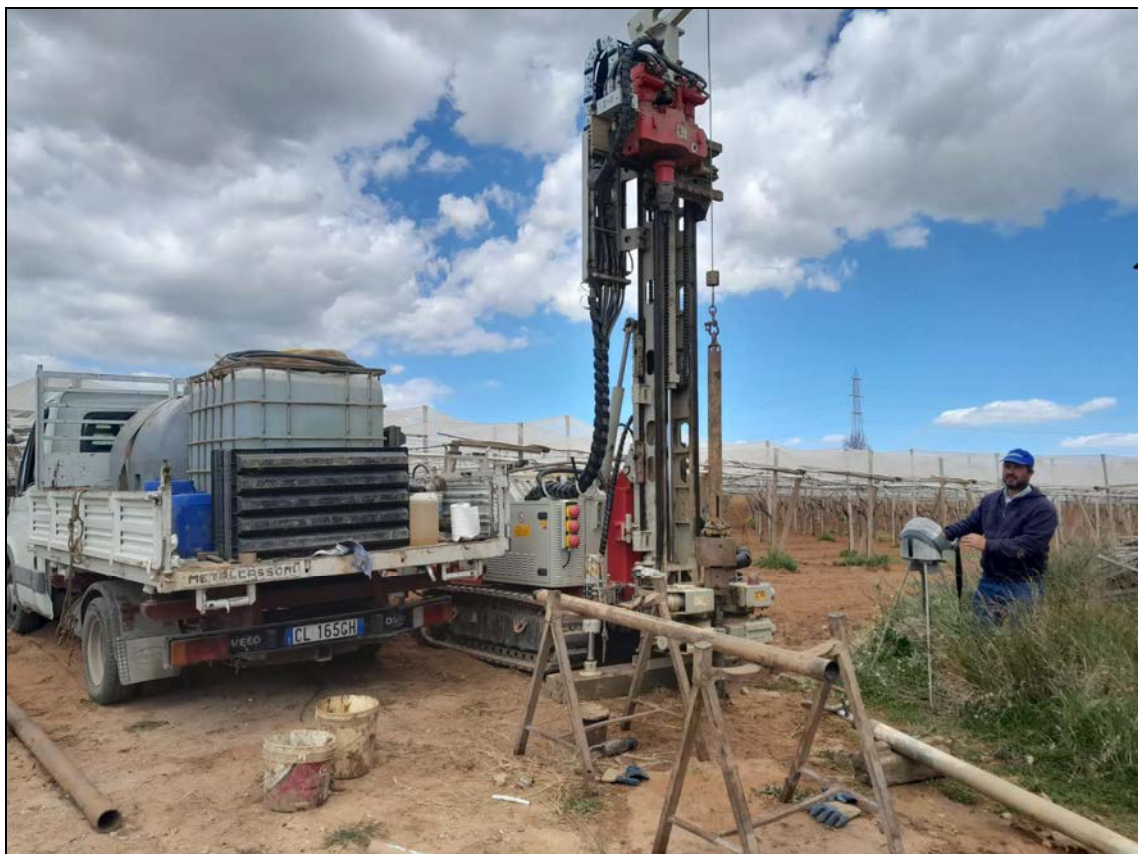
Sonda posizionata durante l'esecuzione del sondaggio meccanico S. 1
