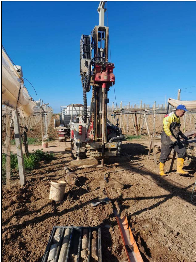
Sonda posizionata durante l'esecuzione del sondaggio meccanico 4
