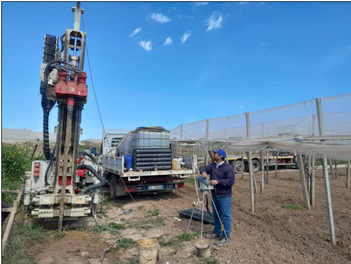
Sonda posizionata durante l'esecuzione del sondaggio meccanico 2
