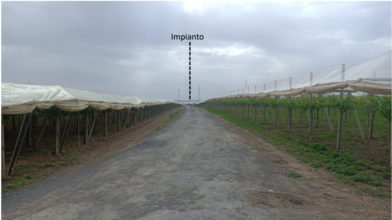
Figura 11 – Vista dal Bene Isolato Opificio Rizza (D3) e Viabilità Storica (ante 1868)- impianto non visibile
