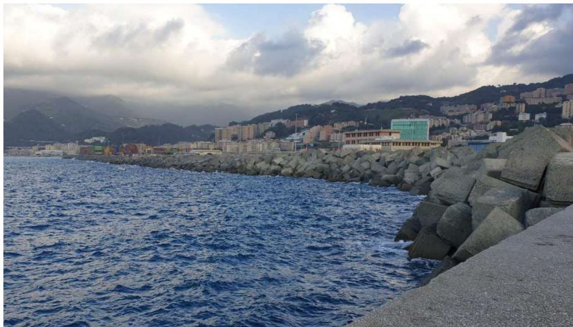
Foto 3: Vista dalla radice diga VTE
