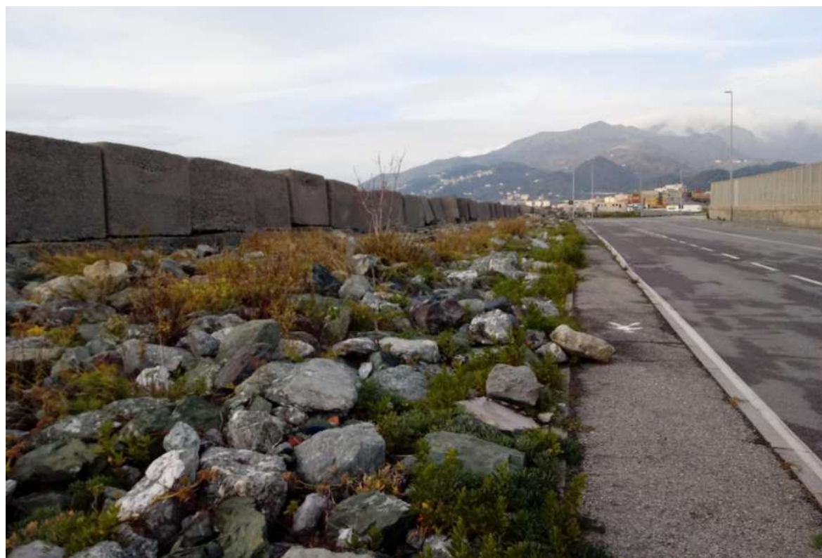
Foto 4: Spazio compreso fra mantellata e viabilità
