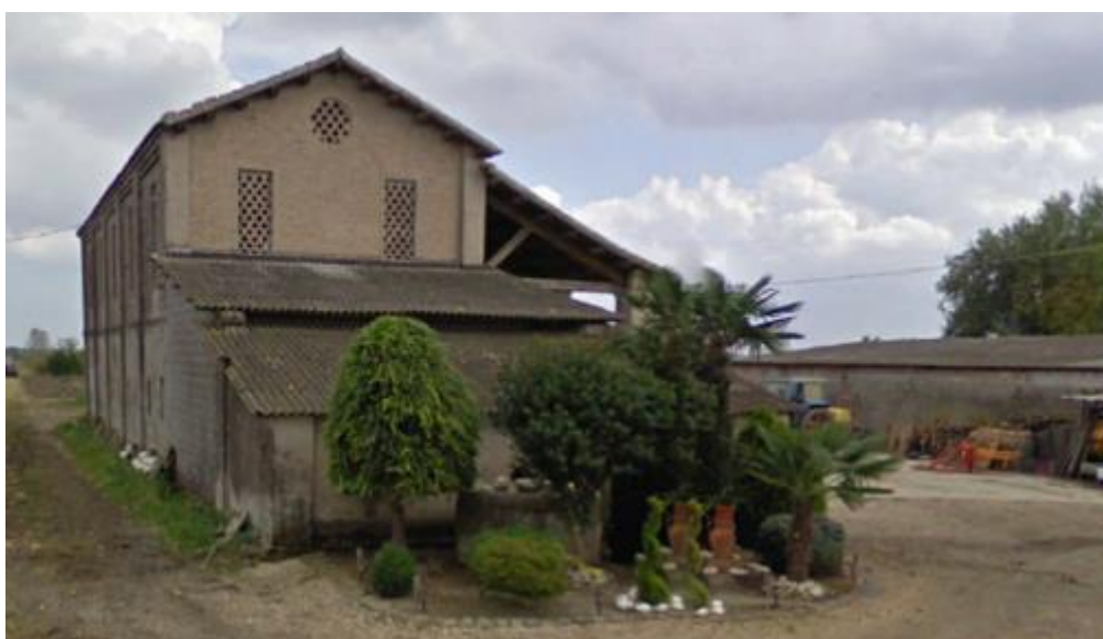
Figura 4-19: Edificio più prossimo all'area di progetto
