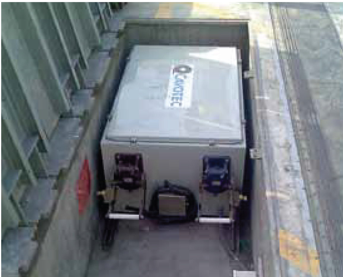
Figura 4 - Esempio di interramento del sistema di conversione
