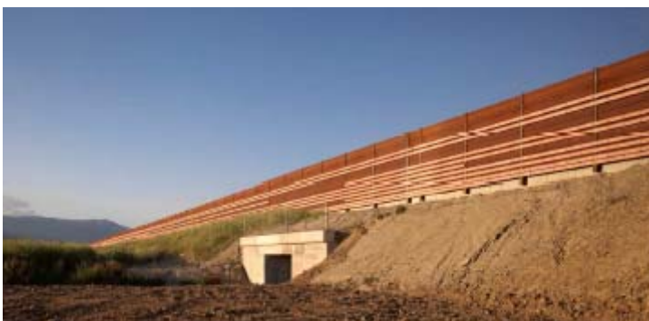
Barriera antirumore in pannelli in acciaio Cor-Ten – vista lato esterno
