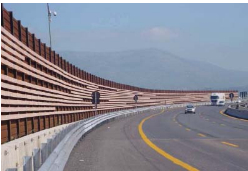
Barriera antirumore in pannelli in acciaio Cor-Ten – vista lato strada
