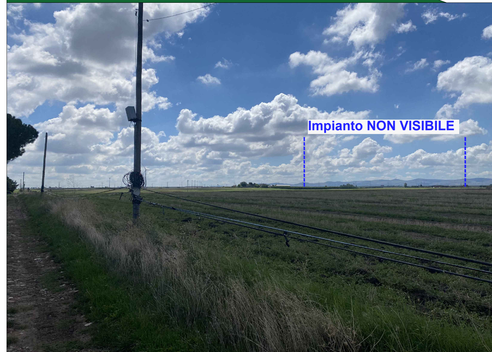
Bene 4_Punto di vista 4A_SUD (post opera)
