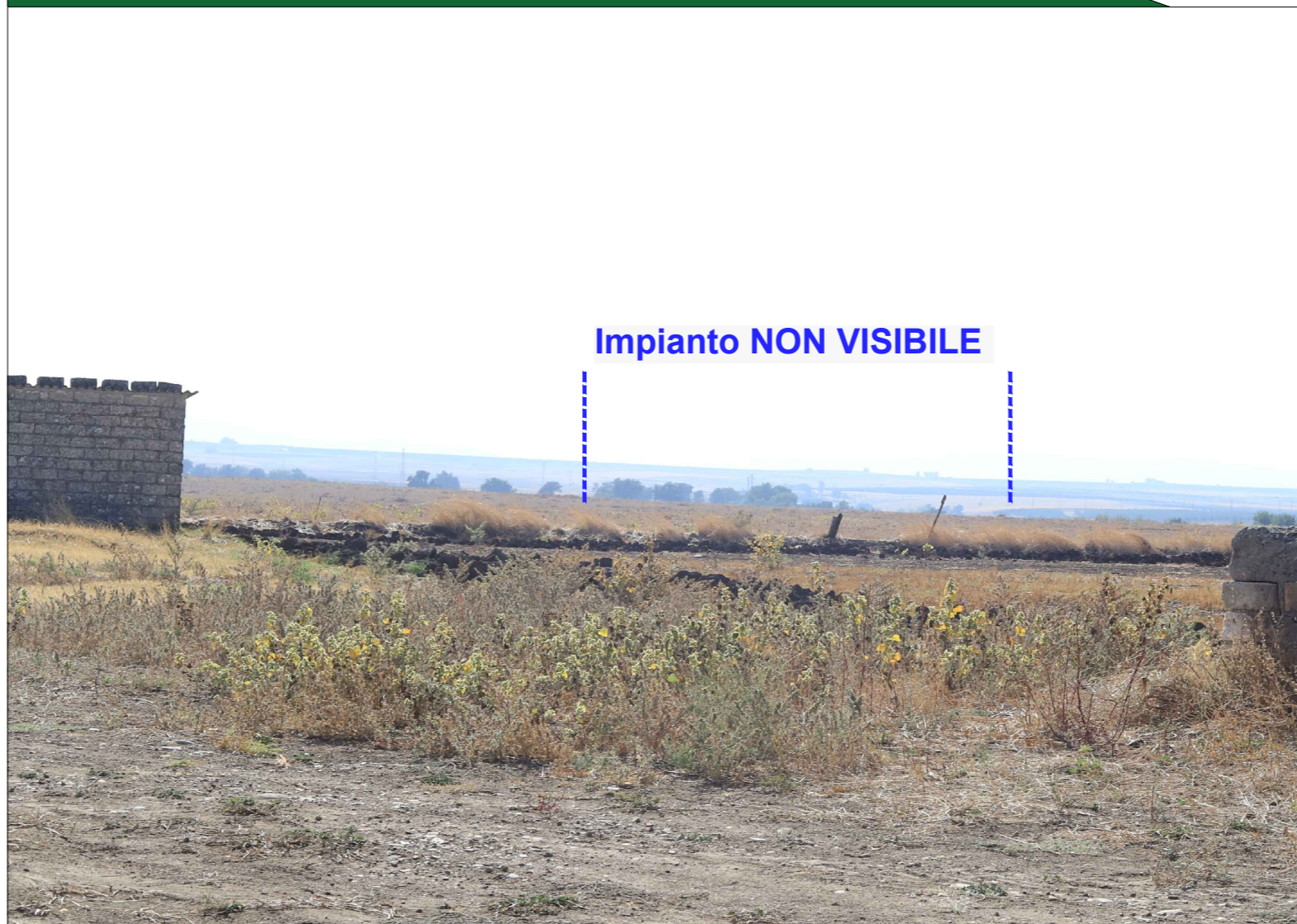
Bene 7_Punto di vista 7A (post opera)
