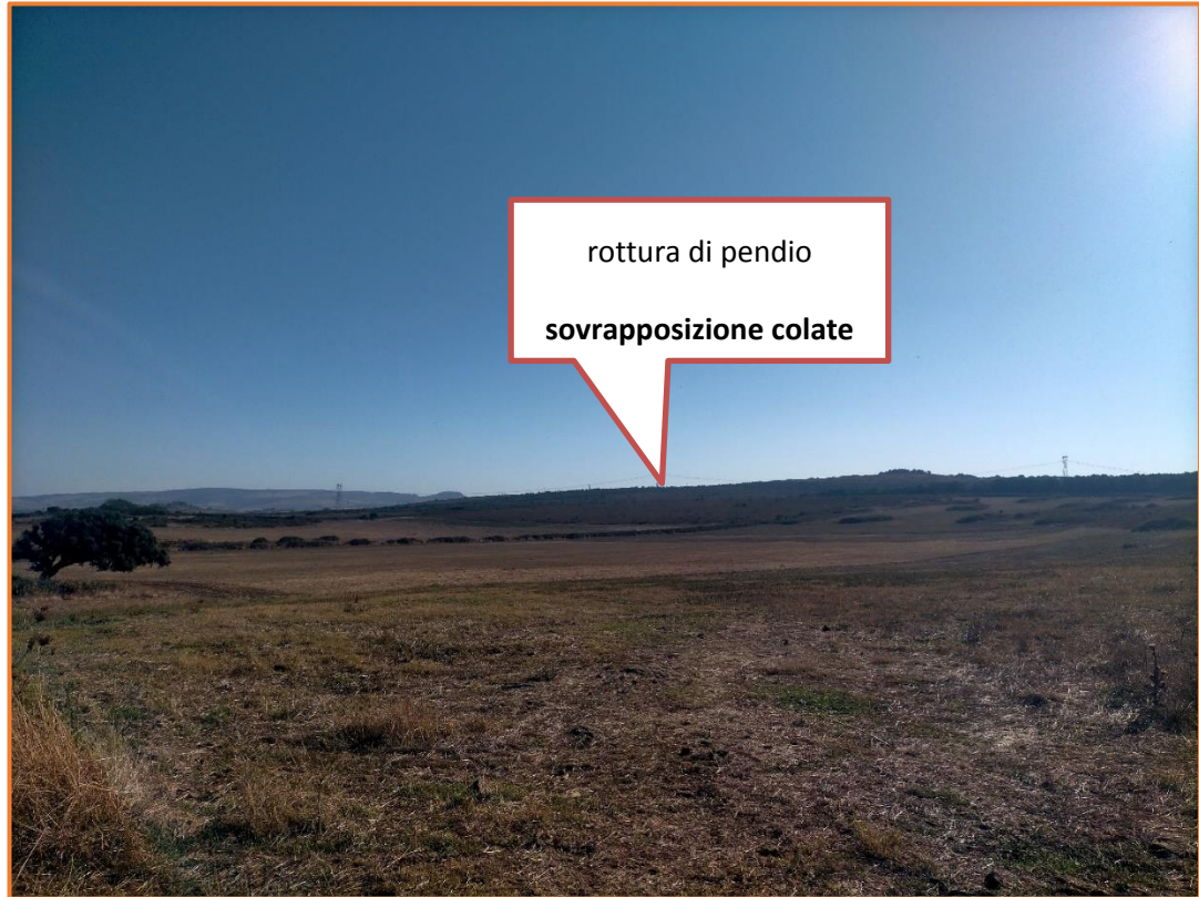
FIGURA 12 – immagine scattata dalla strada sita in località Funtana Lada
