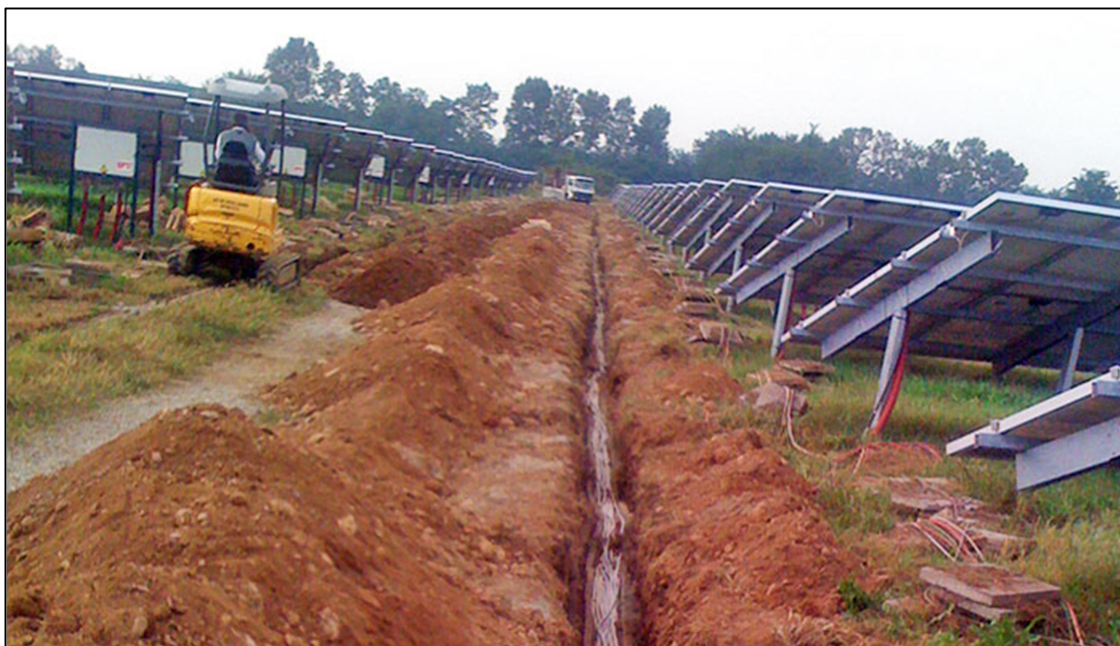
Figura 17 – Tipico di scavo per cavi BT/MT
